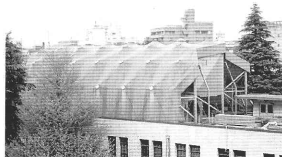
写真1 張力安定トラスドーム：全体モデル（膜あり） （妻面撤去後振動実験を実施）
