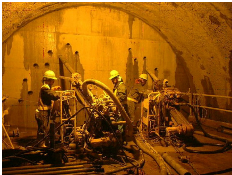
(b) 岩盤注入工法（トンネル）
