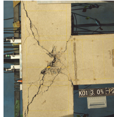
層間変形角 3.0%時
