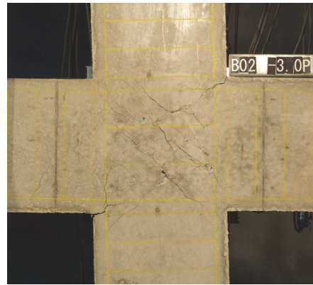
層間変形角 3.0%時
