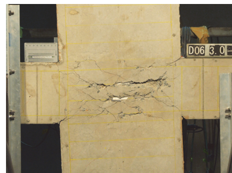
層間変形角 3.0%時
