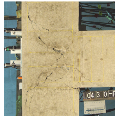
層間変形角 3.0%時
