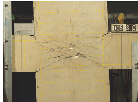
層間変形角 3.0%時
