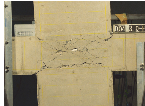
層間変形角 3.0%時
