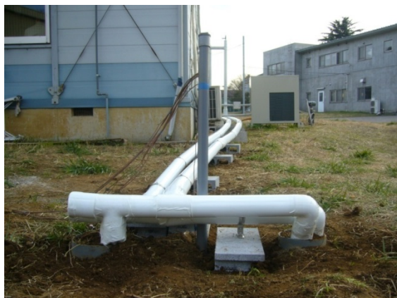
図 7.2.1-8 実験所の地中熱交換器の写真
