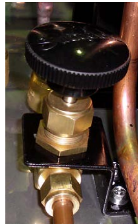
図 5.1.3-5 ニードル弁の外観写真
