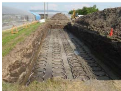
図 7.1.2-3 スリンキーコイル型地中熱交換器の写真 7.7)
