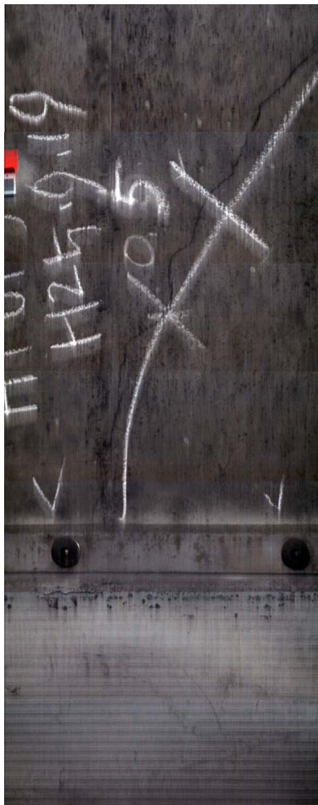
図 4.32. 坂下トンネル下りにおいて時速 70km で走行中に撮像した画像を手動でイメージモザイクキングした様子（撮像後コントラスト補正と色調補正を実行）
