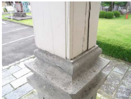
玄関前方柱の亀裂
