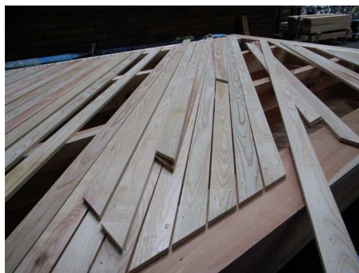
図 3-11（左図） 斜め木摺の施工
