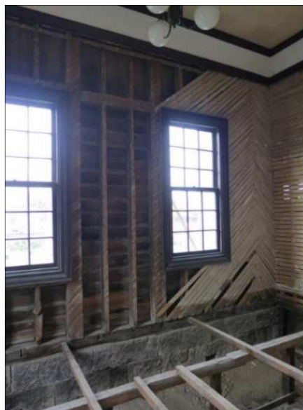
図 3-13 木摺漆喰壁の構成要素 柱，木摺接合部・主要寸法部分詳細
