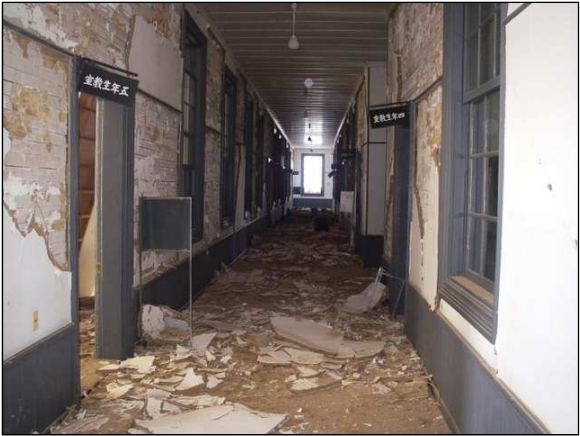
図 2-8 漆喰壁の剥落 (旧福島尋常中学校)
