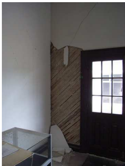
西側壁の剥落
