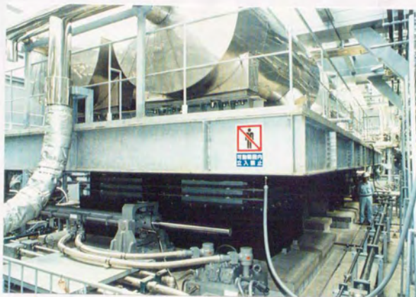
図6.3 アクティブ・マスダンパ全景
