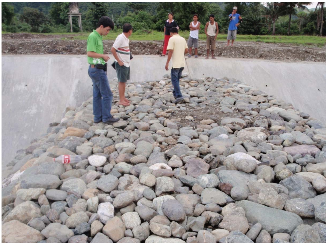
写真 4.6 石積み水制工の完成前検査 (2009 年 7 月 3 日撮影)
