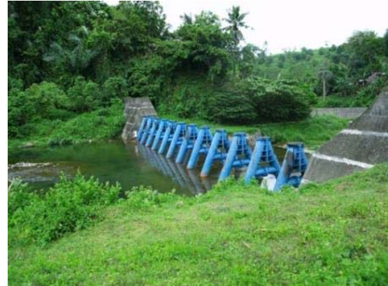
図 5.3 無償資金協力によって造られた鋼製ス リットダム
