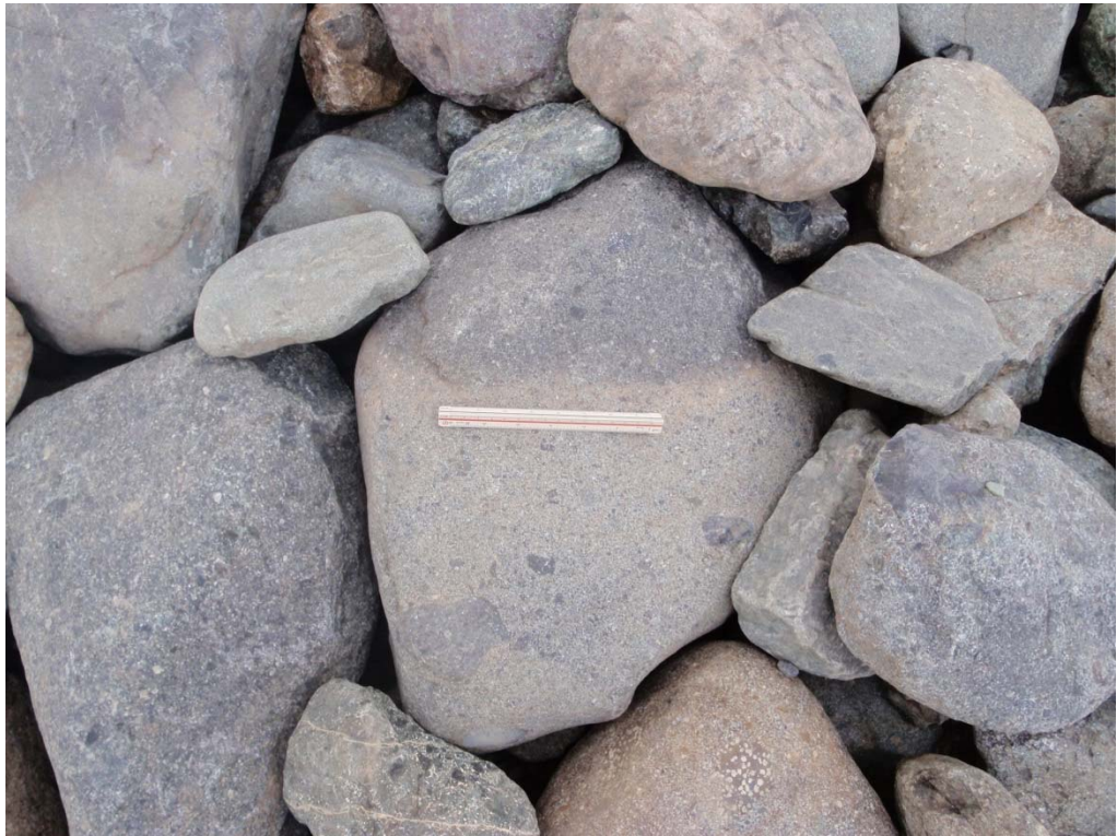
写真 4.5 水制工表面の玉石と 15cm スケール (2009 年 7 月 3 日撮影)
