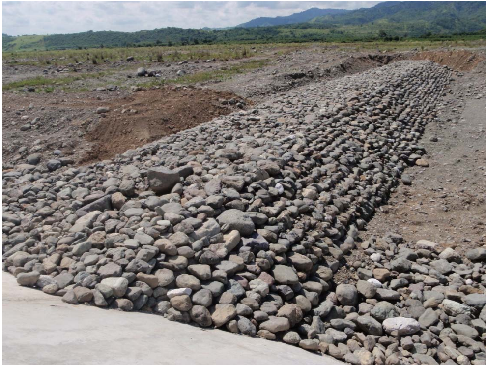
写真 4.7 完成した石積み水制工
