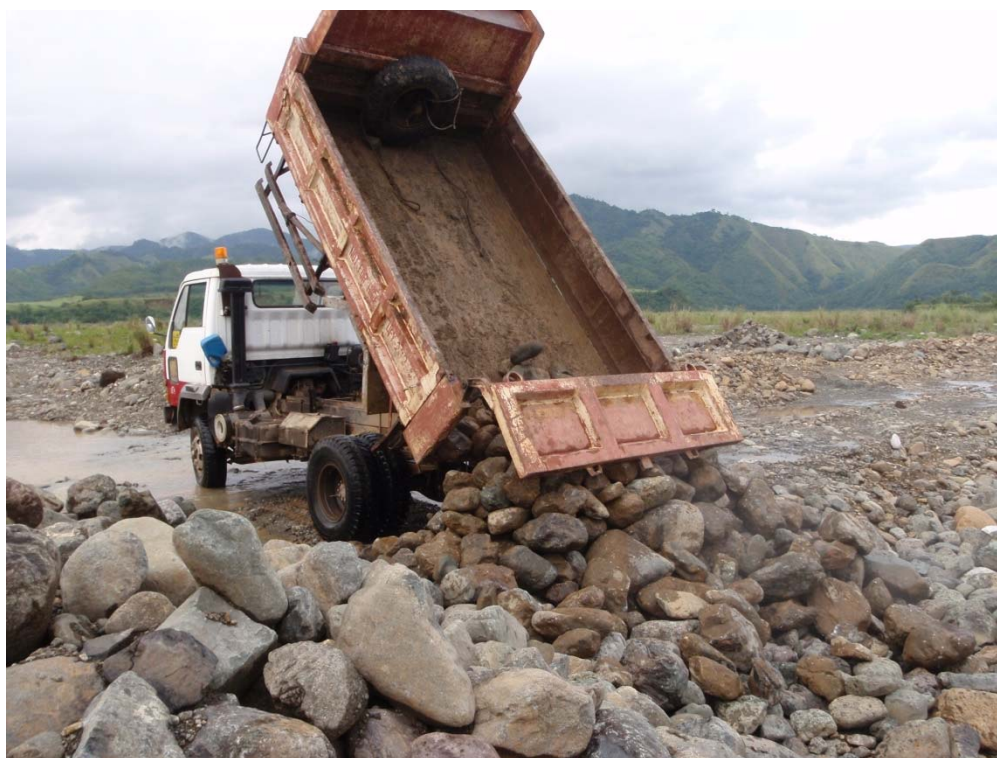
写真 4.4 石積み水制用の石の搬入 (2009 年 6 月 19 日撮影)
