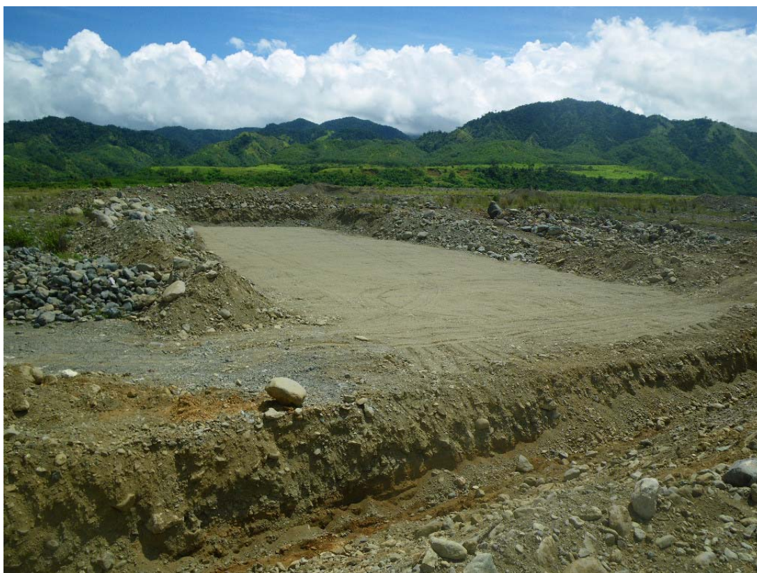
写真 4.2 水制設置箇所の整地と砂利敷均し状況 (2009年5月22日撮影)
