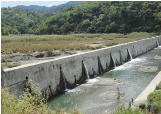
図 5.2 円借款によって造られたコンクリート 砂防ダム
