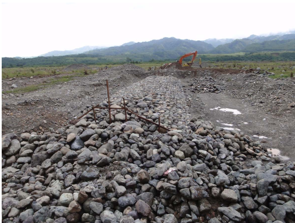
写真 4.3 工事中の水制 (2009 年 6 月 19 日撮影)
