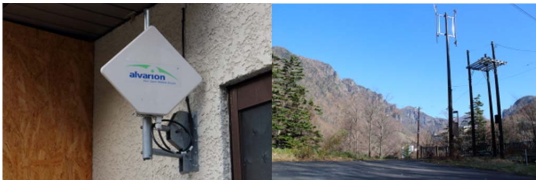
写真 VI-1 宿泊施設に設置されたアンテナ(写真左)と旧層雲峡小学校の基地局(写真右)
