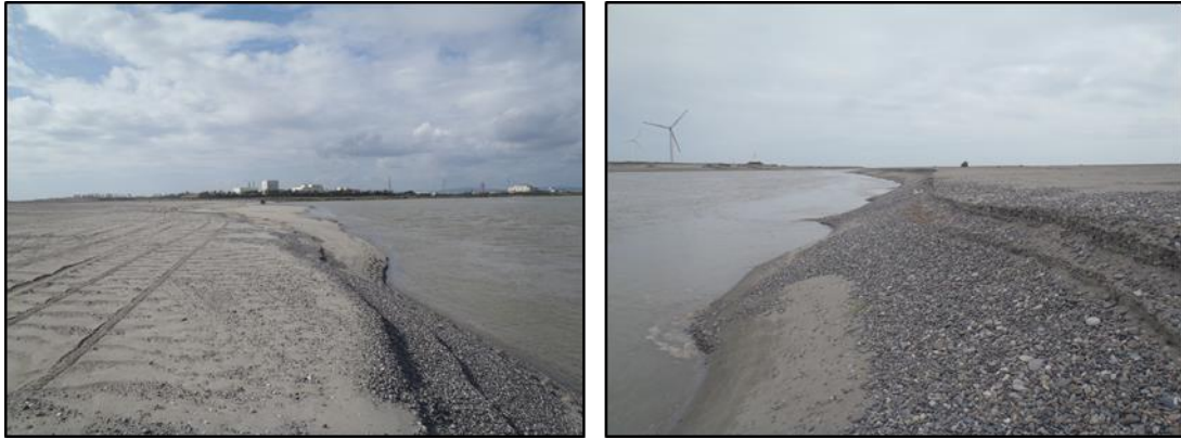
図 3-5-12 部分的に侵食，急勾配化した砂州河道側の状況 (左：砂州中央部から根元を眺望，右：砂州中央部から先端を眺望)
