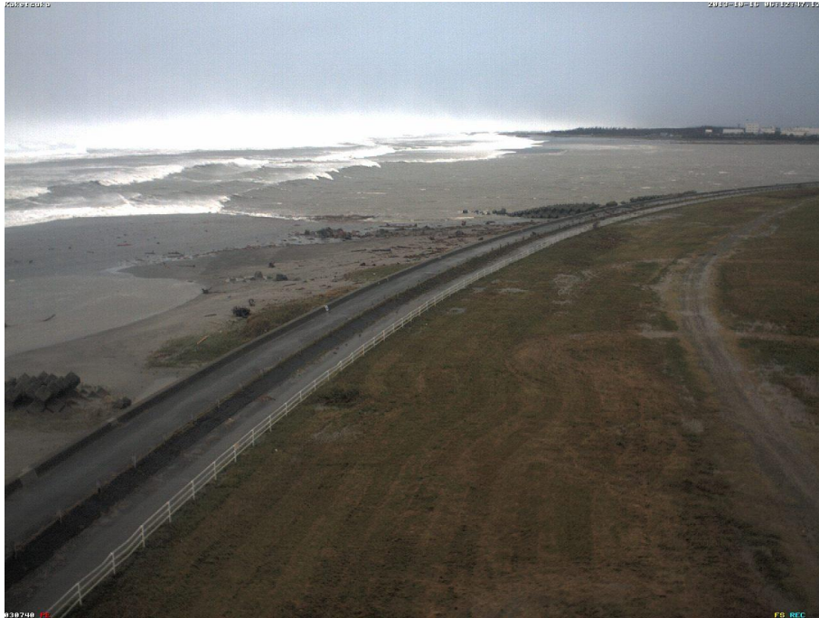
図 2-5-6 台風 1326 来襲時のカメラ画像で捉えた砂州越波の様子 (左岸から右岸砂州を望む)
