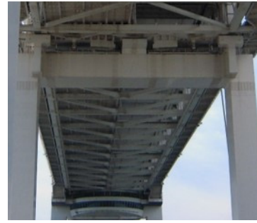
(c) 端橋脚変位制限装置
