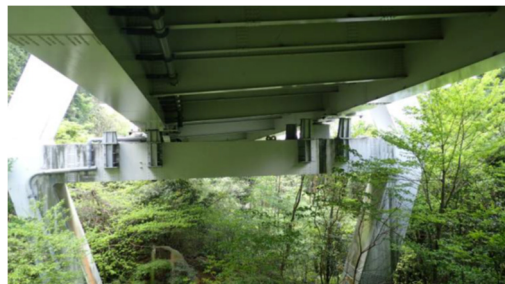
(c) 主塔部における支承からの桁脱落
