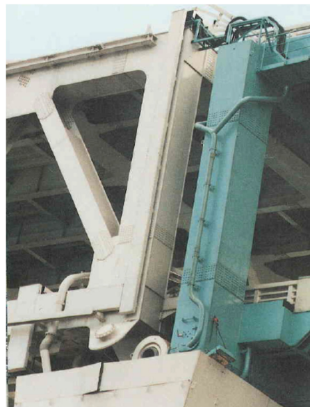
(d) 桁端部のアップリフト
