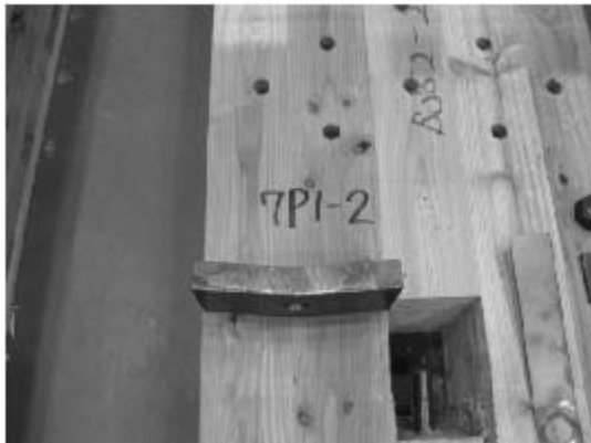
写真 6.4-27 P77-2 座金の曲げ変形
