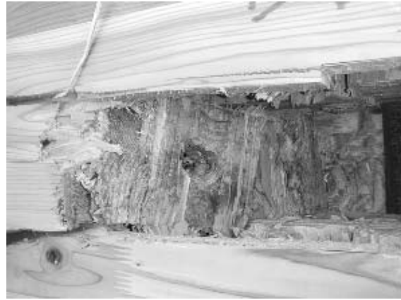
写真 4.4-19 Mx60B-6 座金下部のめり込み
