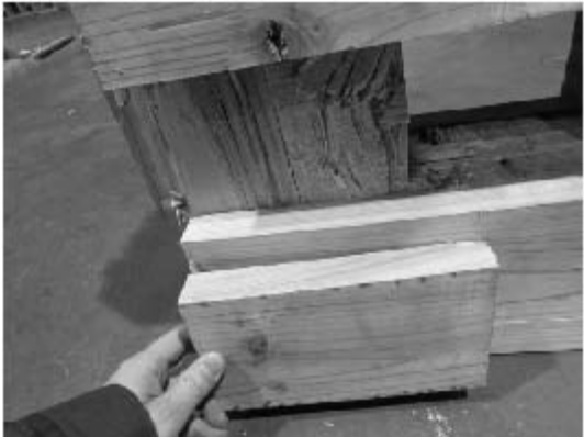
写真 5.4-25 Mx60APS 1520-2 座金下部 両脇の積層接着面のせん断木部破壊
