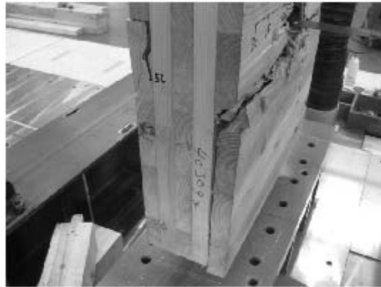
写真 6.4-56 055D-1 積層接着面のせん断木部破壊
