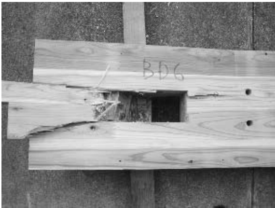
写真 4.4-18 Mx60B-6 積層接着面のせん断木部破壊
