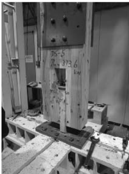
写真 4.4-26 DS-5 積層接着面のせん断 木部破壊
