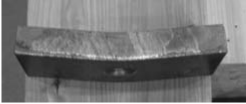
写真 6.5-3 座金の曲げ変形
