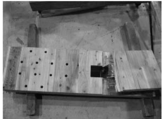
写真 5.4-14 S30AOC1550-3 座金下部外層の割れ+積層接着面のせん断木部破壊
