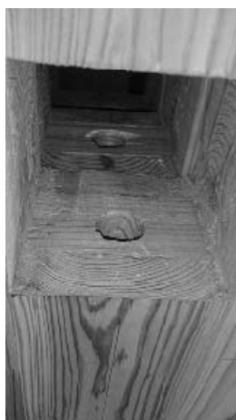
写真 3.4-1 引きボルト接合部のための角穴
