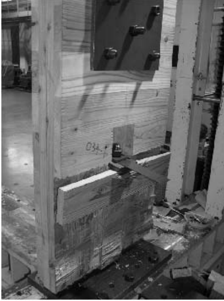
写真 6.4-43 034-1 積層接着面のせん断木部破壊
