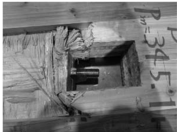
写真 4.4-8 S30A'-6 座金下部のめり込み 積層接着面のせん断木部破壊
