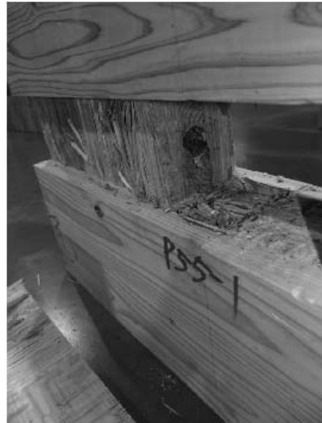
写真 6.4-14 P55-1 座金による圧縮降伏、積層接着面のせん断木部破壊
