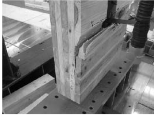
写真 6.4-62 055D-4 積層接着面のせん断木部破壊
