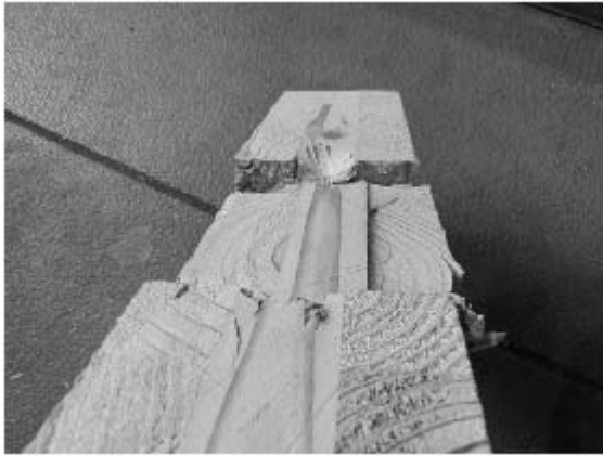
写真 3.7-17 CP33 めり込み、直交層の復元力によって平行層との間に割裂
