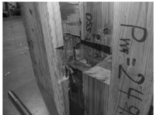
写真 4.4-54 試験体 055-2 解体後
