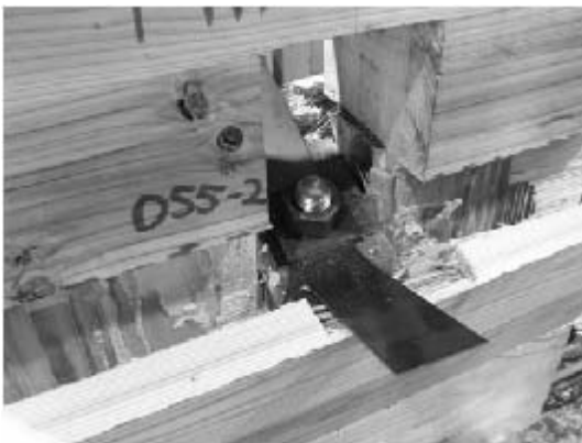
写真 6.4-53 試験体 055-2 積層接着面のせん断木部破壊
