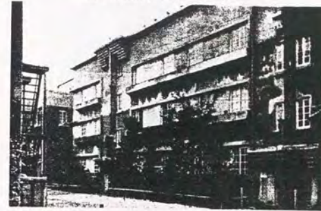
図 65.昭和5年の5号館写真 10
