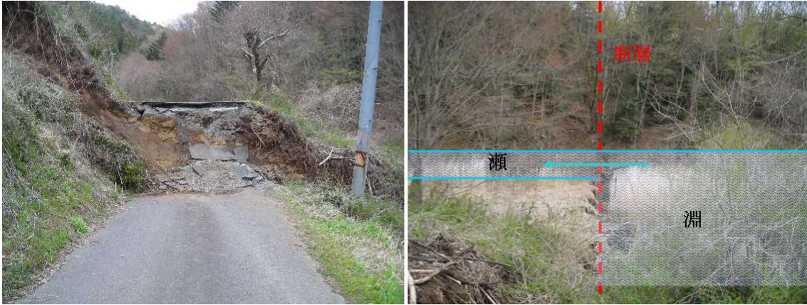
図 3.1.4 塩ノ平地区でみられた地表変状（岡谷・小荒井, 2011a をカラー化） 左図は道路に生じた段差を示し、右図は川がせき止められ淵状になっていることを示す。
