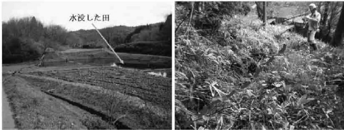
図 3.1.5 塩ノ平北方地区でみられた地表変状（岡谷・小荒井, 2011a） 左図は水田の水没や段差の発生を示し、右図は 家屋東側の段差の発生を示す。
