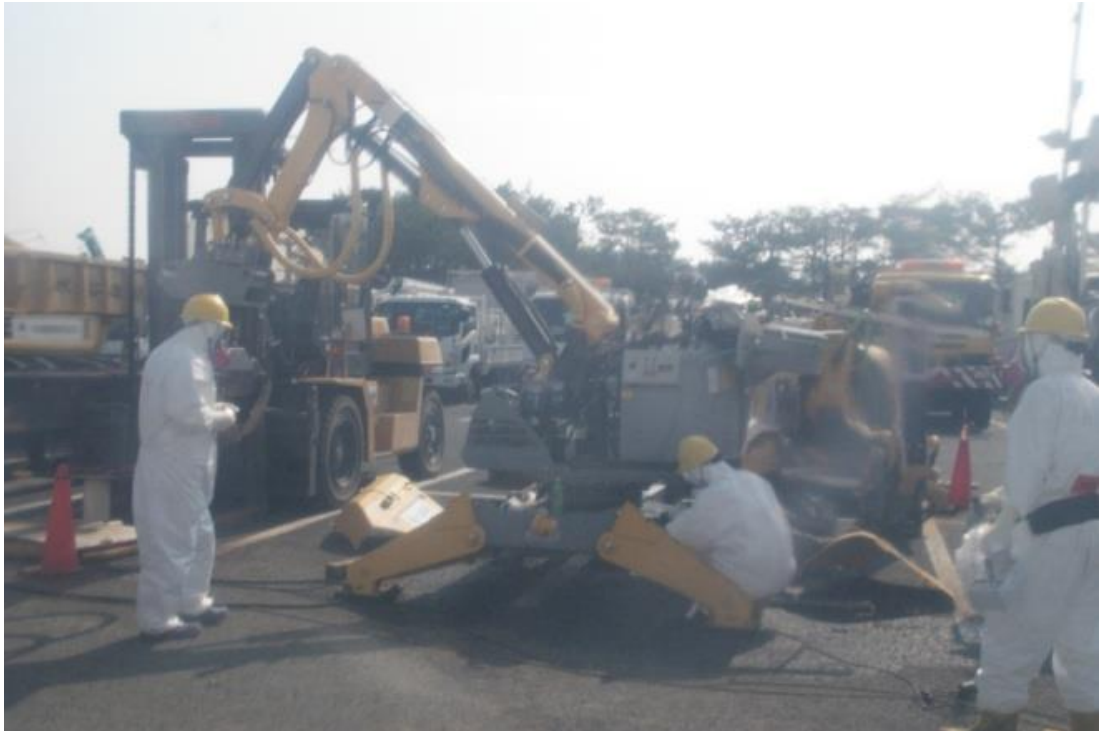
図 7-8 Brokk-330D のスプロケット部の除染作業
