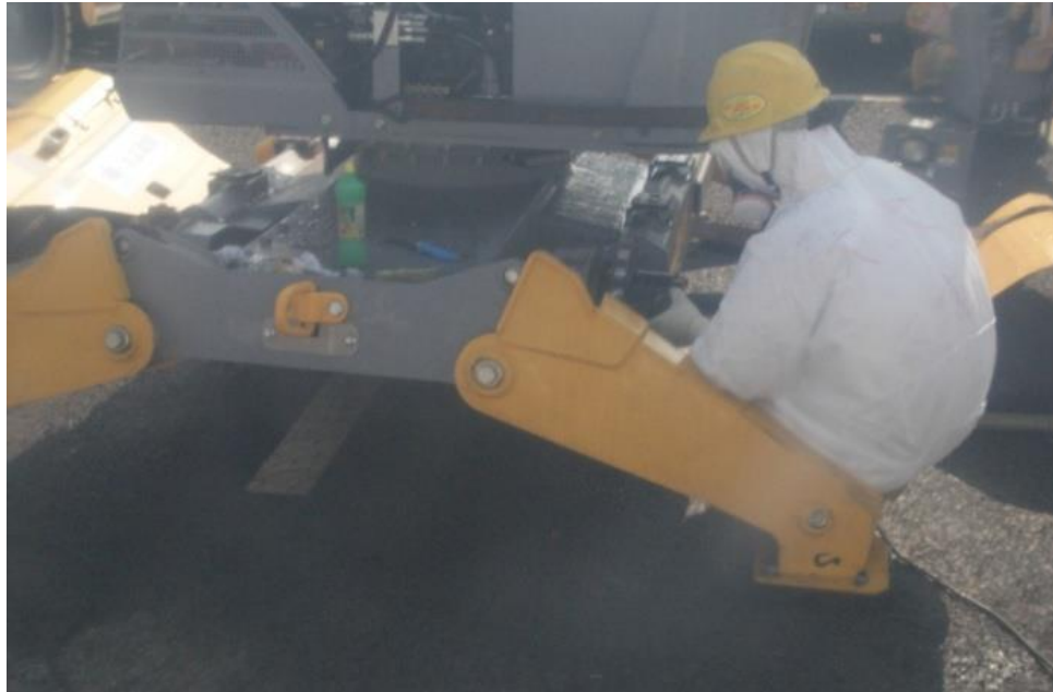
図 7-7 Brokk-330D の汚染検査と除染作業
