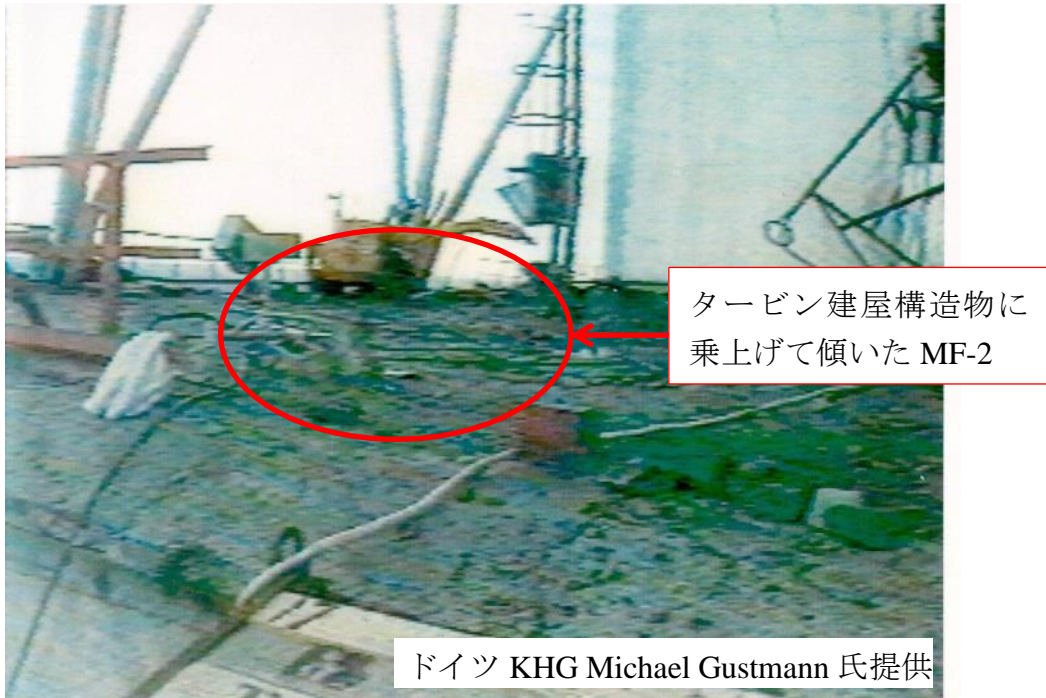
図 22 タービン建屋屋上で瓦礫等の撤去に用いられている MF-2
