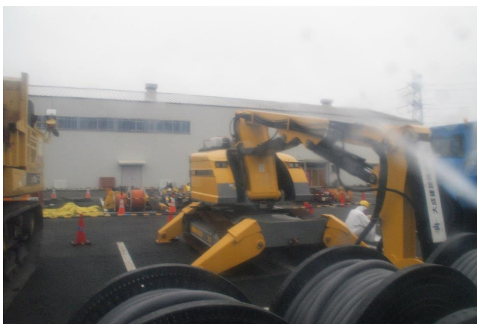
図 2-18 除染後も汚染が残った Brokk-800
