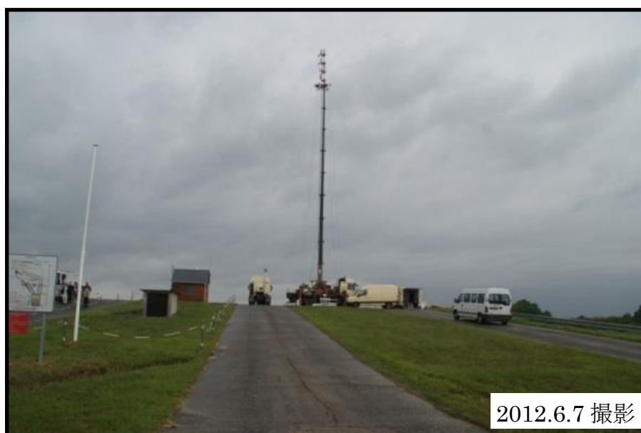
図 6 33 m マストの先端に取り付けられた遠距離通信用無線アンテナ
