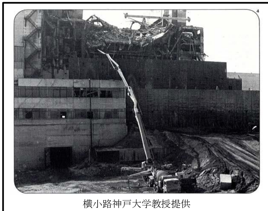
図 27 石棺建設のためのコンクリートポンプ車による工事
