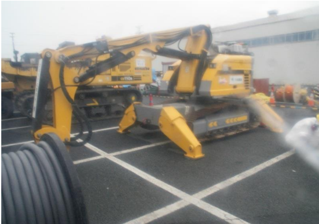
図 7-6 福島第一原子力発電所内で除染を待つ Brokk-800D
