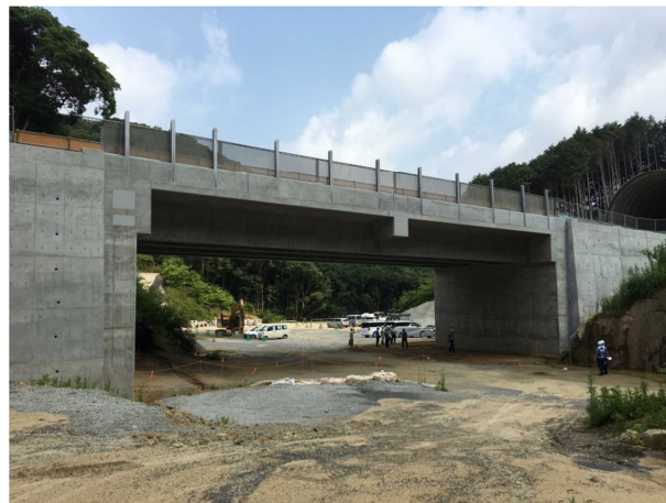
図 2.3.6 九州新幹線（西九州ルート）原種架道橋
