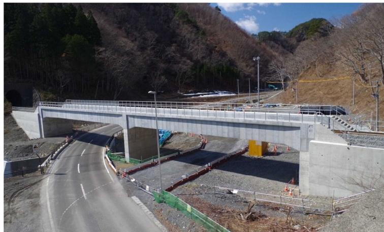
図 4.1.4 三陸鉄道北リアス線ハイペ沢橋梁
