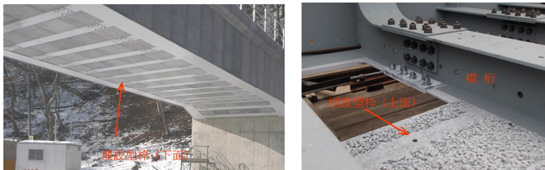
図 4.1.5 埋設型枠
