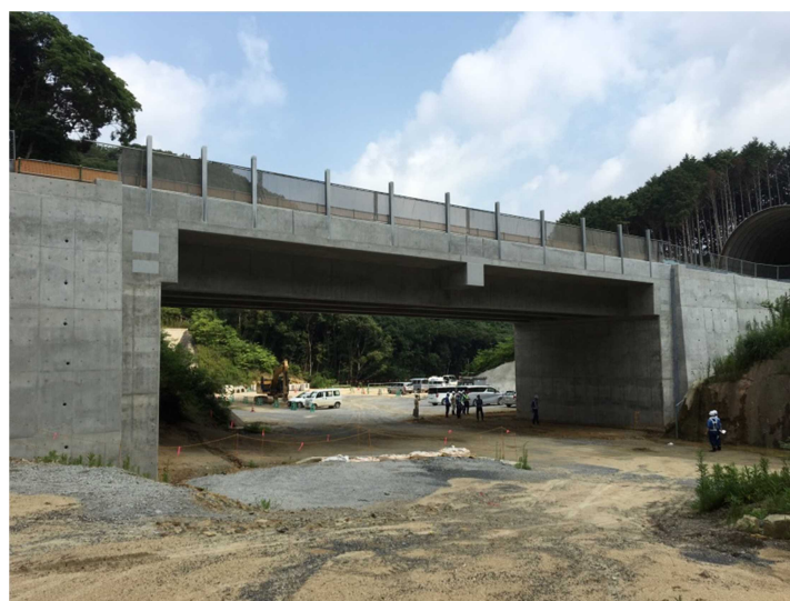
図 6.1.4 現地の施工状況
