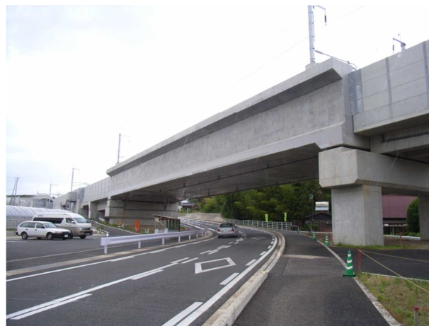
図 4.3.1 下路桁の例
