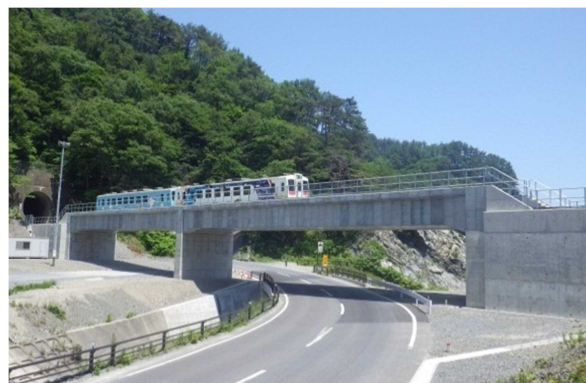
図 2.3.5 三陸鉄道北リアス線ハイペ沢橋梁
