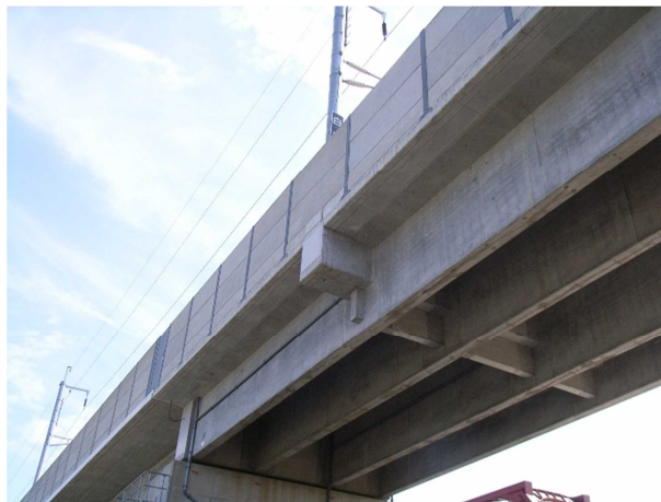
図 5.1.1 PC-T 形桁
