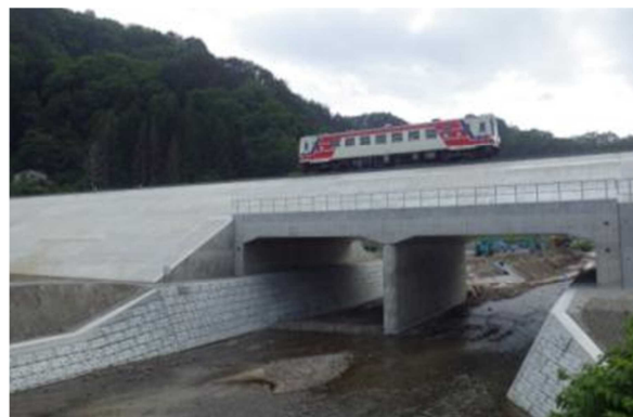
図 2.3.3 三陸鉄道北リアス線松前川橋梁
