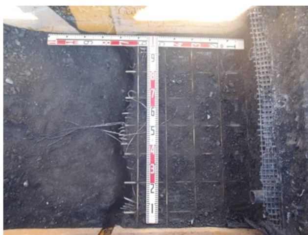
図 4.6.5 載荷実験後の緩衝層に発生した亀裂
