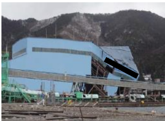
写真 2.1 KIS-01 の衝突による崩壊建築物
