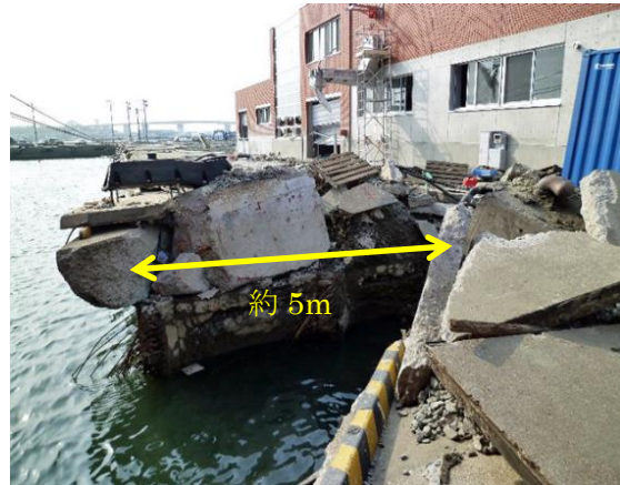
図 3.13 船舶(HHE-12)衝突による岸壁の損傷 [3.9]
