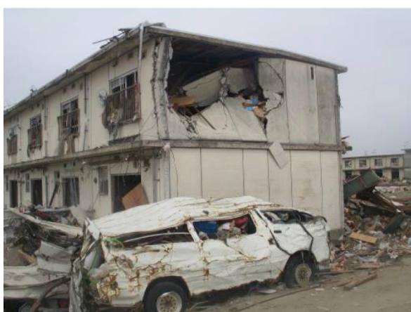
(e) 外壁が破壊された建築物 宮城県名取市 [1.9]
