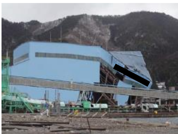
(f) 船舶衝突による崩壊建築物 岩手県釜石市 [1.10]
