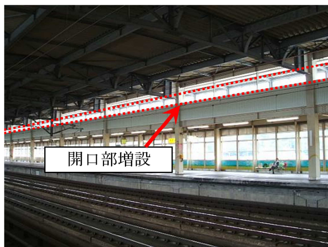
図 4-1 A 駅開口部増設状況
