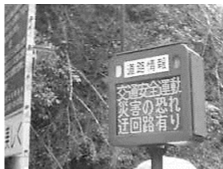
図 8-2 稼働中の道路情報提供装置(KL1 型) 出所：高知県土木部道路課(2013)
