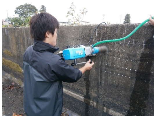
(d) コンクリート・コアの採取
