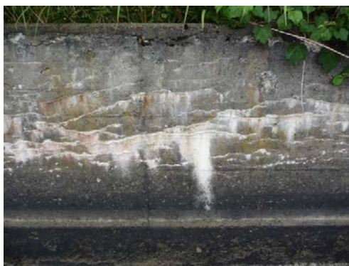
(a) 凍害損傷が顕在化した水路側壁
