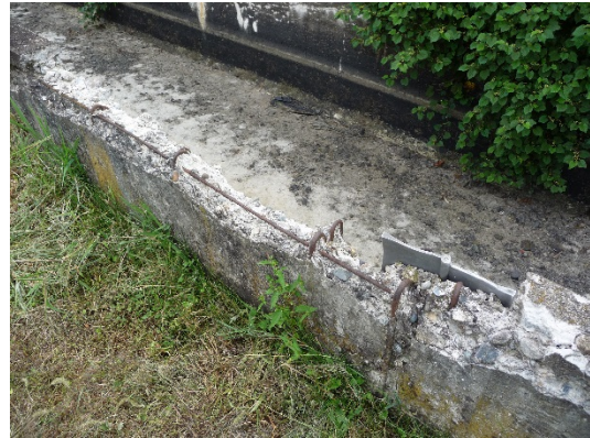
(b) 側壁端部の崩壊
