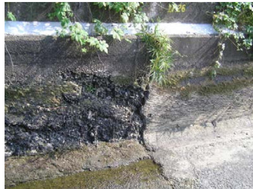
(b) 磨耗損傷が顕在化した水路側壁
