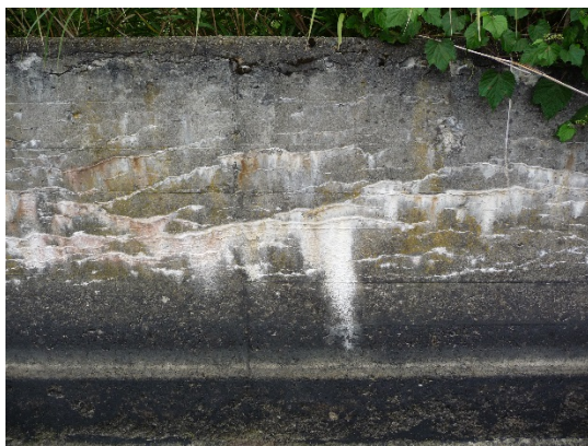
(c) ひび割れ損傷の発達状況
