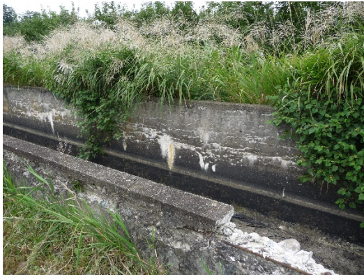
(a) 凍害損傷が顕在化した水路側壁
