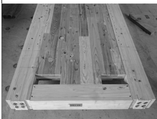
写真 2.3.81 CW-6 柱脚
