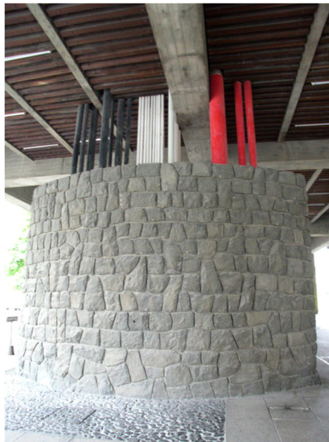
図 3-83 043 香川県庁舎 配管の下部だけ石垣で覆っている (2003年 筆者撮影)
