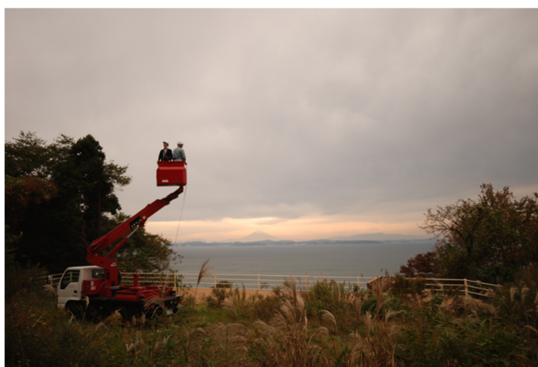
図 4-20 高所作業車による高さと景色の確認
