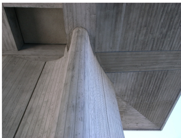
図 3-30 007 広島平和記念資料館 (柱脚の局面と型枠の痕跡) (2010年 筆者撮影)
