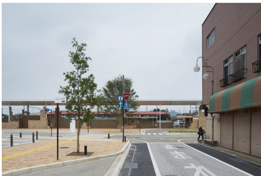
図 4-29 上州富岡駅を街側から見る（竣工時） (c) 阿野太一
