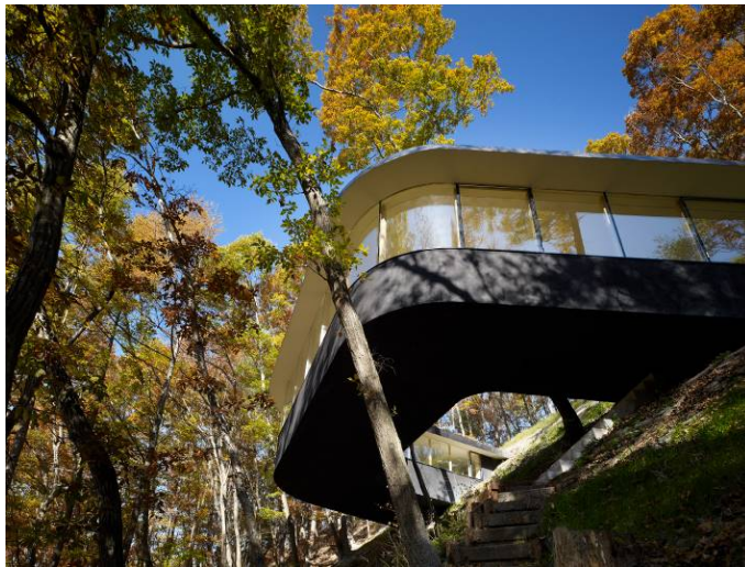
図 4-17 廊の家 崖下から建物を見上げる ((c) 阿野太一)
