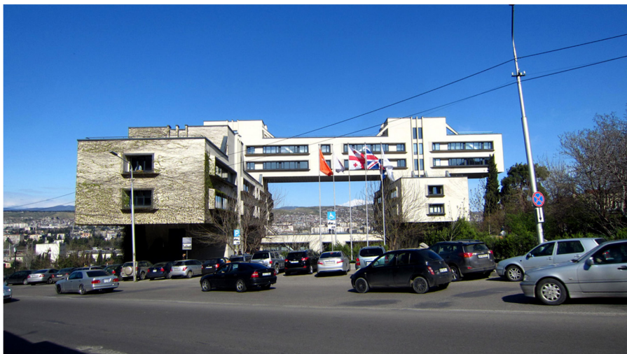
図 2-97 旧高速道路建設省 崖上から見る（現：ジョージア銀行）（1975）
