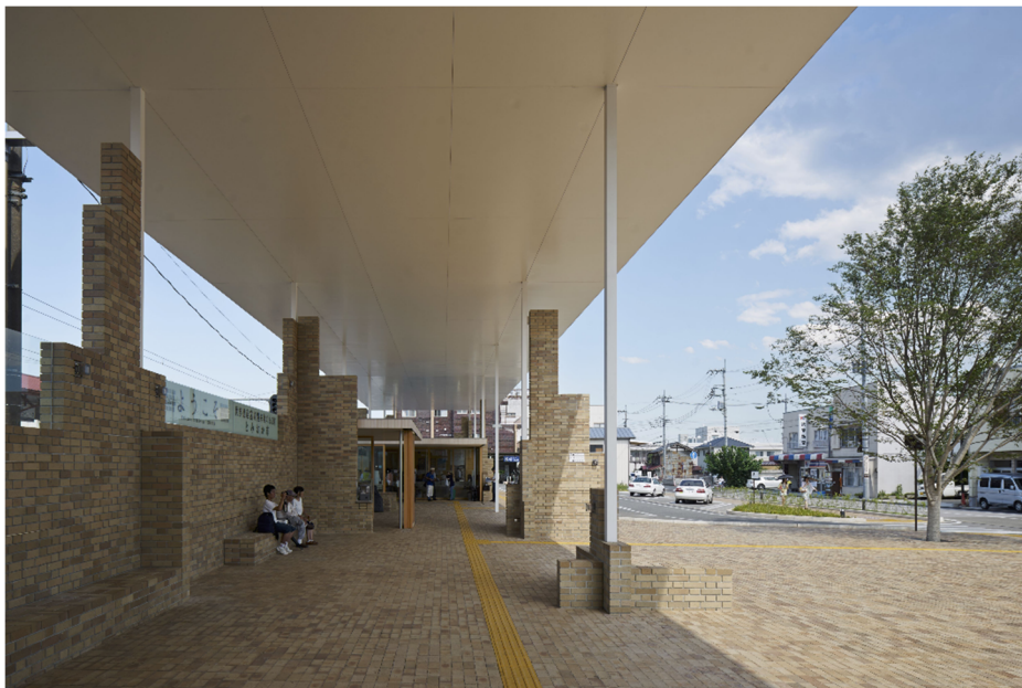
図4-94 完全に街に開放されている市の誘致スペース
