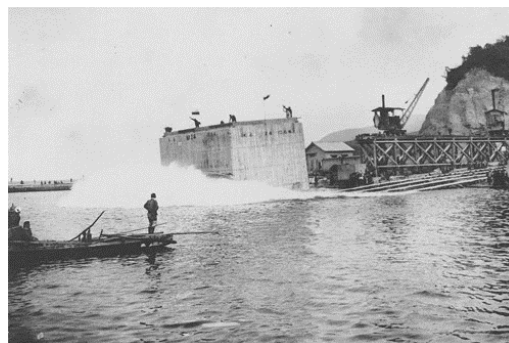
図19 小樽築港のケーソン斜路進水作業（出典：同図12）
