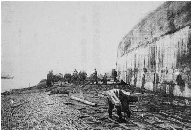
図 16 艋舺地先に築造された淡水河コンクリート擁壁堤防 (A-B 断面)。淡水河とともに発展してきた港町の艋舺と大稻埕との市街地は水運機能、空間、生活、景観が完全に堤防から同河と隔絶された。(出典：『台湾総督府における鉄筋混凝土構造物写真帖』、1914 年)
