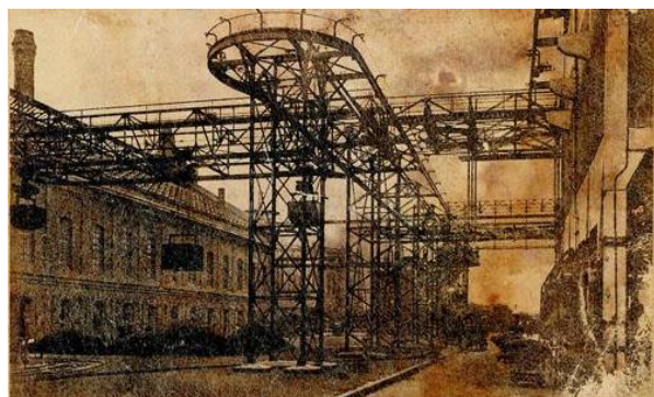
図 28 ドイツのガス工場の架空電力式石炭運搬装置 (出典：同前掲図)
