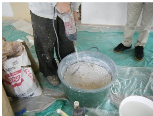
写真 2.1 PCM 内装左官材の作製
