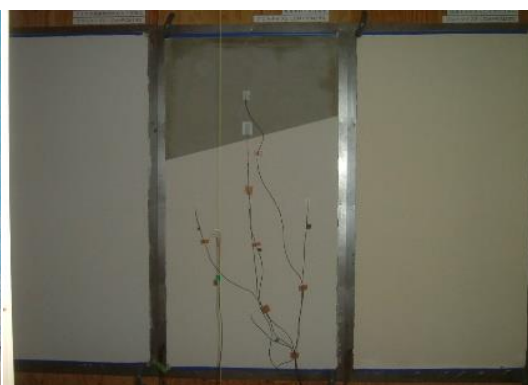
写真 5.4 仕上げ材設置後
