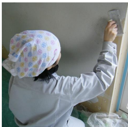
写真 2.2 PCM 内装左官材の施工
