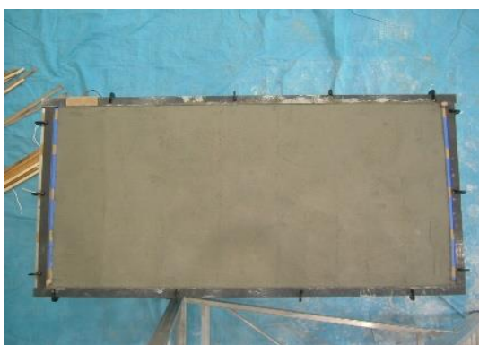
写真 5.3 PCM 内装左官材施工後
