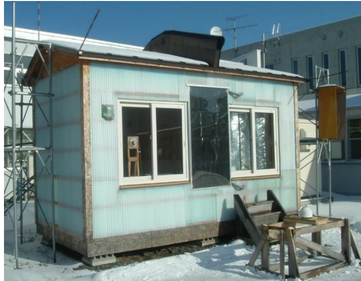
写真 5.8 太陽熱集熱器が設置された実証実験棟の外観
