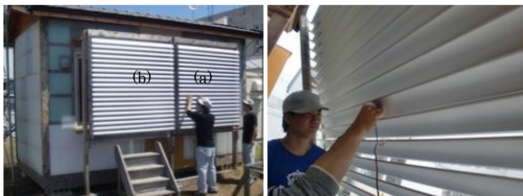
写真 6.12 PCM ブラインド設置状況 写真 6.13 ブラインド背面の状況
