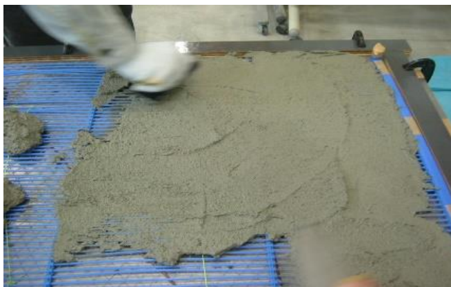
写真 5.2 PCM 内装材の施工
