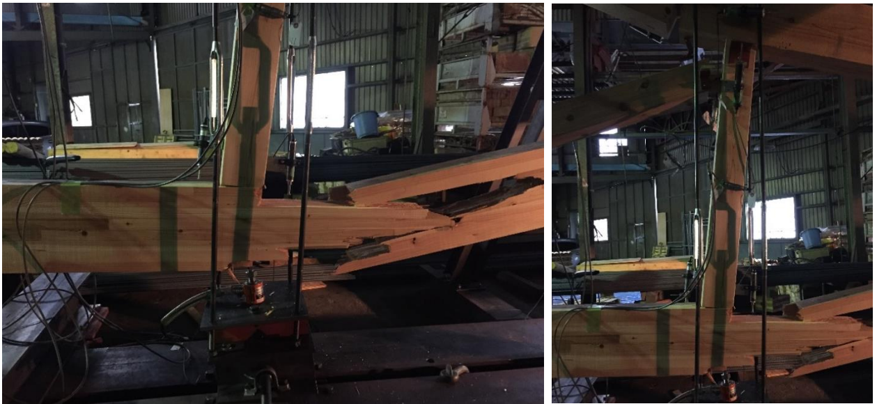
図 4- hEWT_12s-2 試験体 最終破壊状況_真束下の陸梁の曲げ引張破壊
