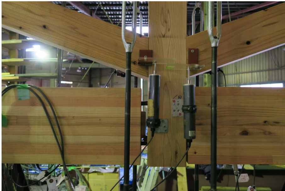
図 4- hEWT_12s-3 試験体 真東下陸梁継手の開き
