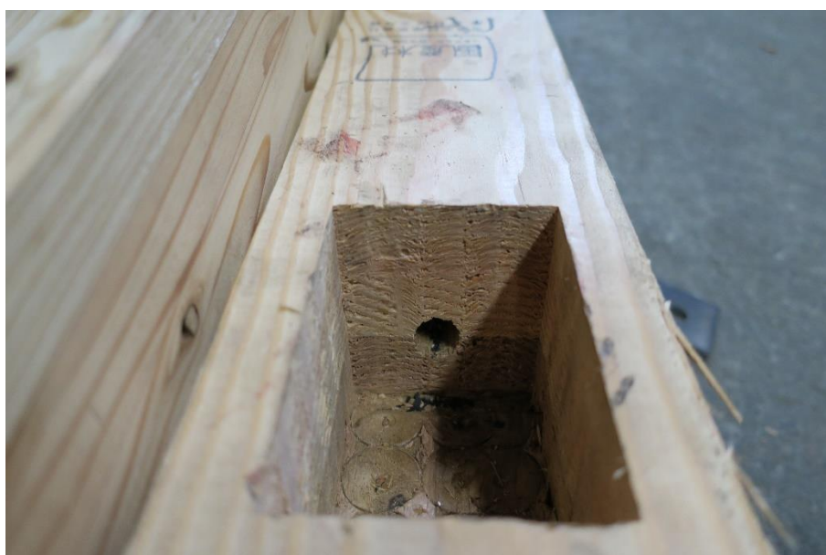
図 5- 陸梁継手の試験終了後の座金支圧面の状況
