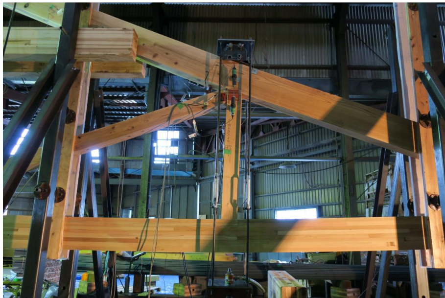
図 4- hEWT_12s-2 試験体 最終破壊状況__側束付近
