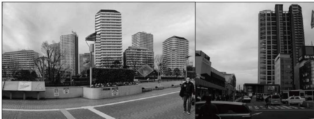
図4-1 郊外鉄道駅前の超高層集合住宅(左図:川口駅、右図:ひばりヶ丘駅、いずれも筆者撮影)
