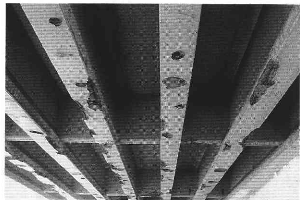
写真1 塩害による鋼材腐食を生じた橋梁上部工
