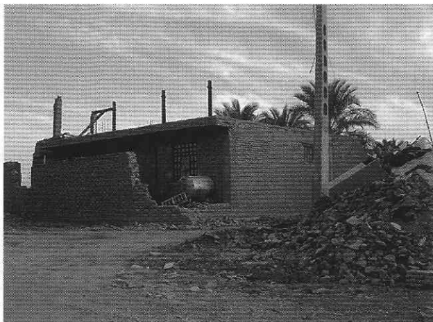
図8 タイ付組積造とそれに接続するレンガ造の壁
