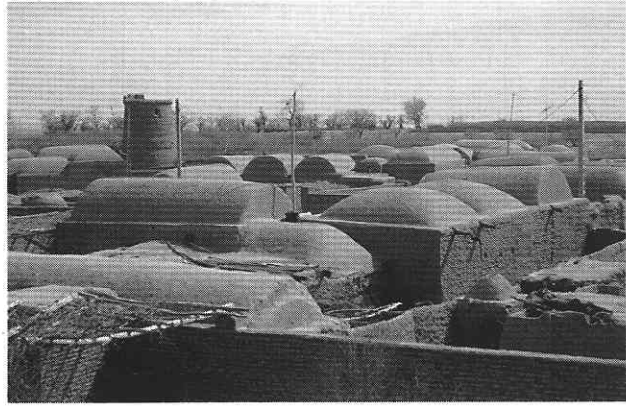
図 2 健全なアドベ造建物群
