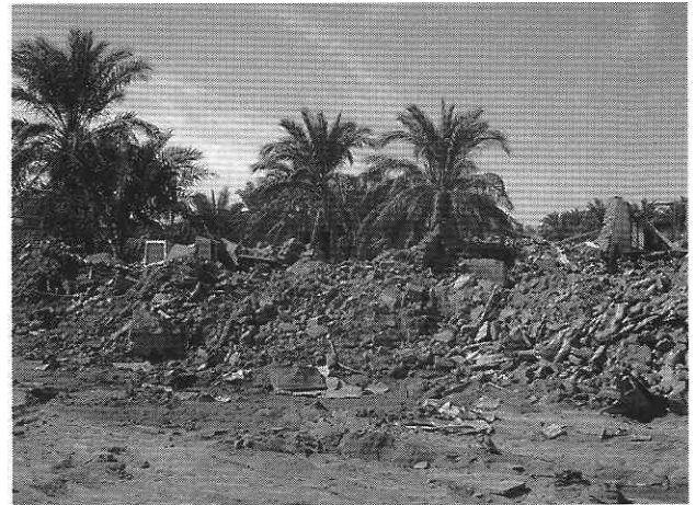
図5 完全に崩壊したアドベ造建物
