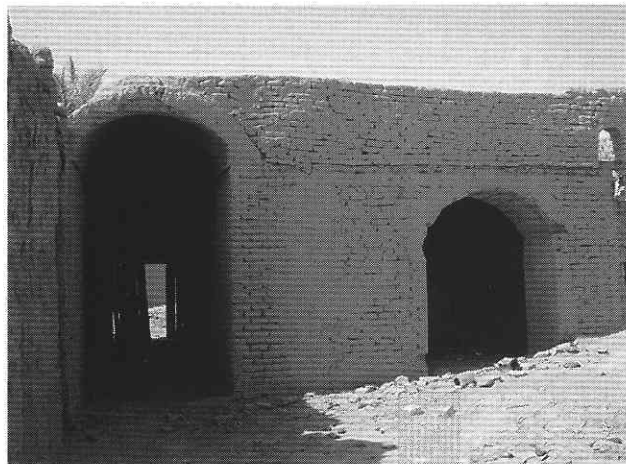
図 3 老朽化したアドベ造建物
