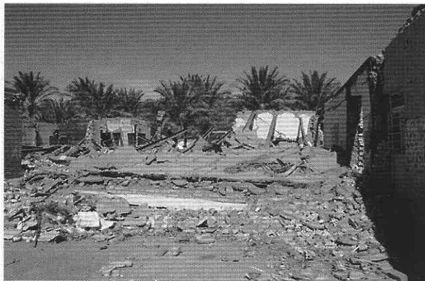
図11 崩壊したレンガ造の学校校舎
