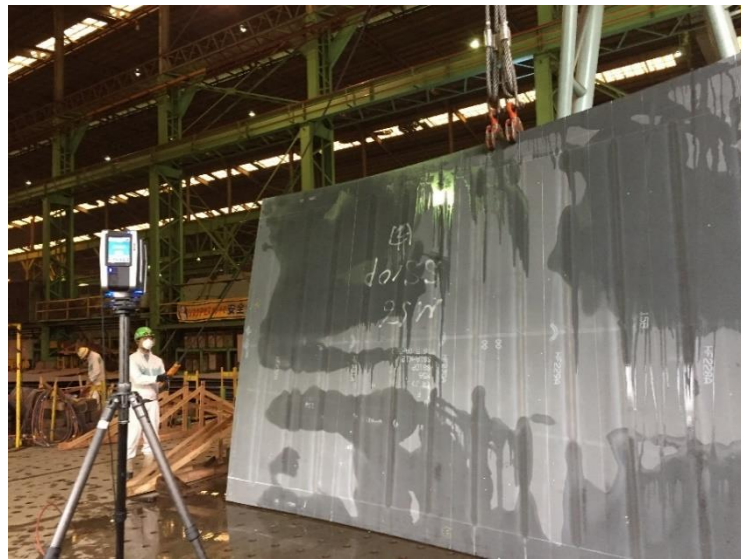
図 4-4 クレーンによる外板の反転作業の様子
