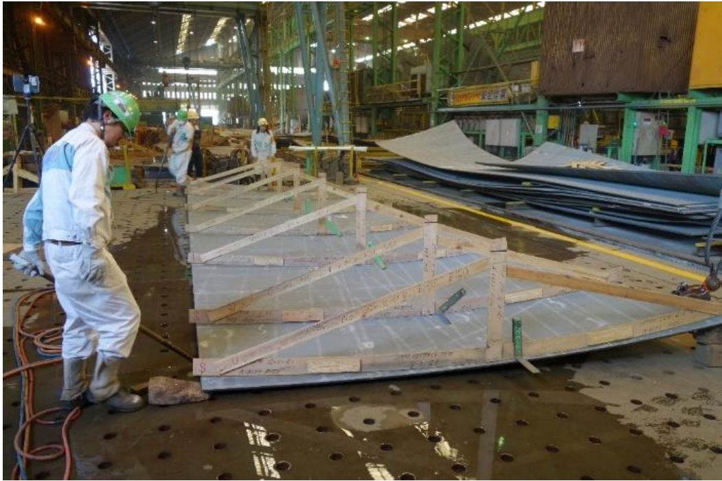
図 7-13 木型を並べた状態での枕木の調整
