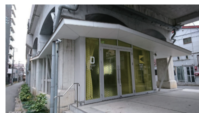
写真 3-2 高架下の多目的スペース 4
