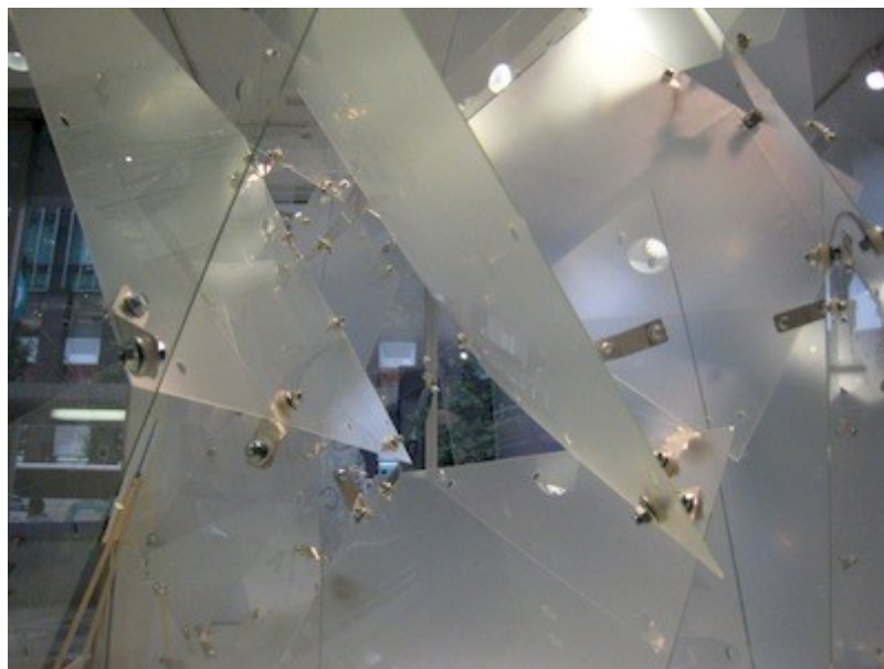
図 1.2.5 超薄板強化ガラスのインストールの接合部 図 ( http://a-plus-e.blogspot.com/2015/06/agc-studio.html より抜粋)
