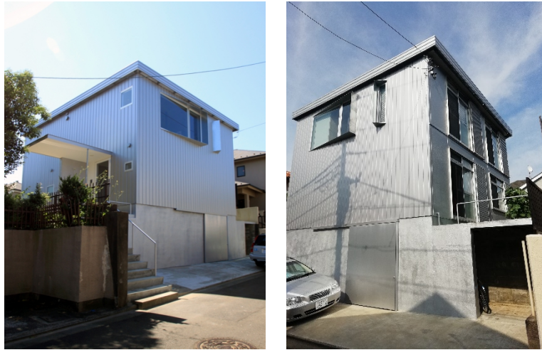
図 5-1 左) 新規外壁の2面 右) 右面は既存外壁 52
