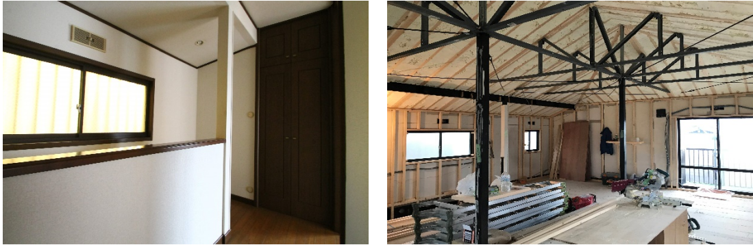
図 5-14 左) 改修前の内観 右) 改修時の様子
