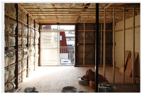
図 5-9 断熱材充填
