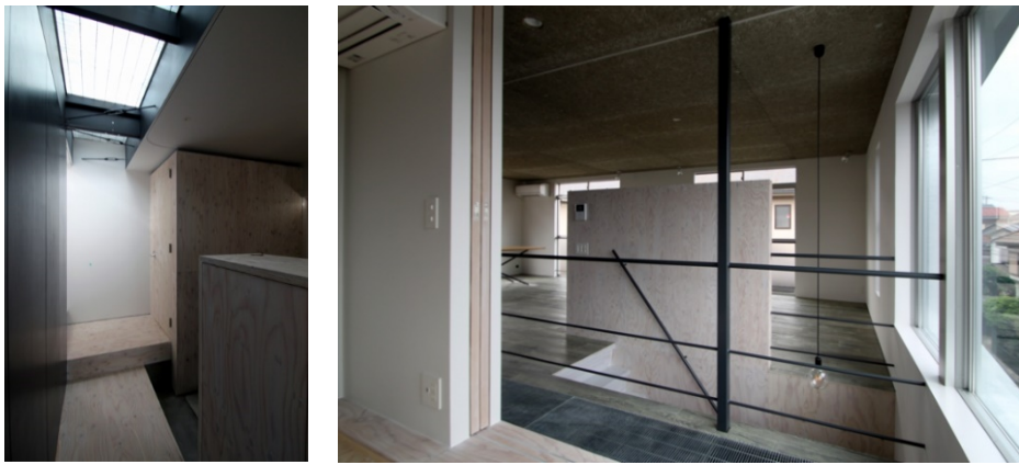
図 5-3 左) 一階廊下の天井見上げグレーチング 右) 右が新しい開口部 53
