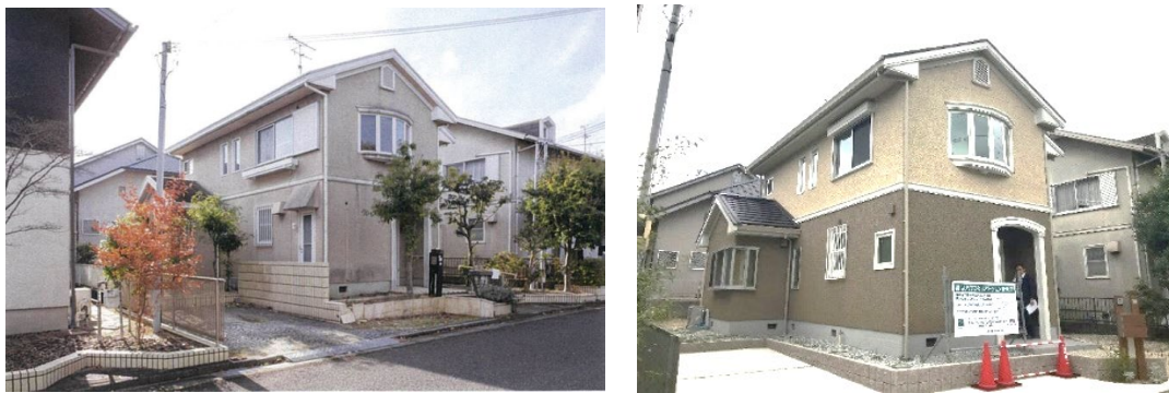
図 3-7 左) 改修前の概観 右) 改修後の概観 47
