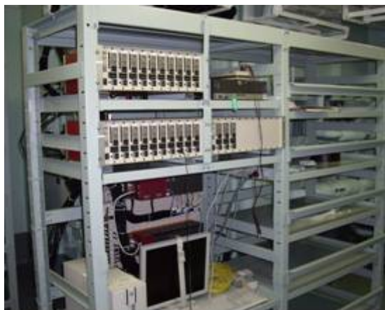
図 4-5 第1観測室歪計測アンプ
