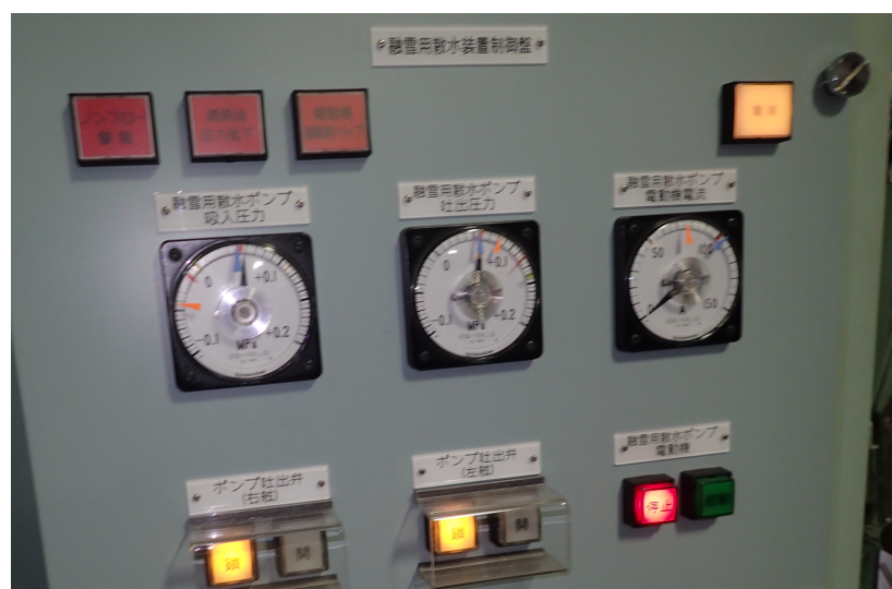
図 4-13 散水装置制御盤
