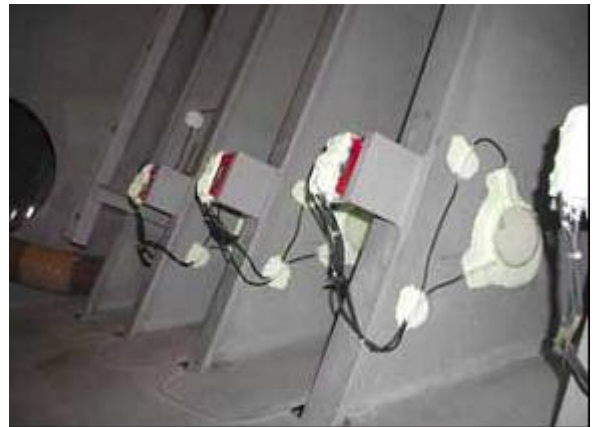
図 4-8 第 2 空所フレームせん断歪計測ゲージ
