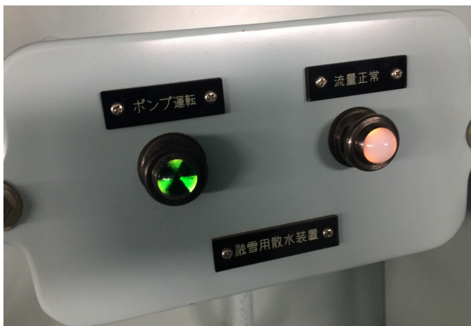
Fig. 2-12 船橋における散水装置の運転確認ランプ
