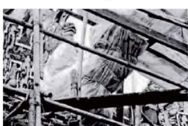
図 2-67 灰塑職人作業の様子 (出典：「広州市歴史建築修繕図則」)
