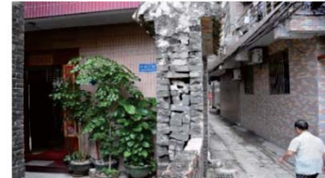
図 2-44 空心双隔壁の充填物
