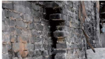
図 2-43 空心双隔壁の断面
