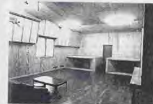
(写真) スタジオはフラッターエコーを防ぐために、壁や天井は微妙に角度をつけてある。また、低音スピーカーは質量が重要なので、据え置きとしてコンクリートで直接打ち込んで製作されている。床も振動を防ぐ構造になっている。
