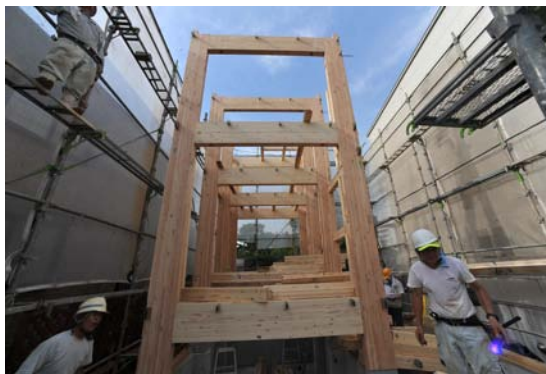
写真 6 直交梁の設置とラーメン梁(片側ピン)の設置
