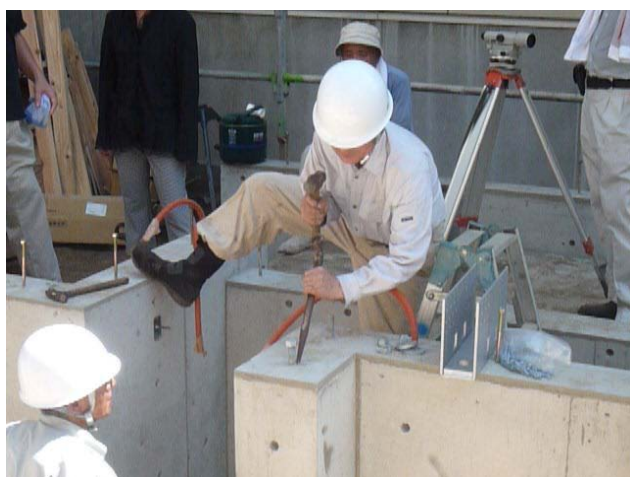
(12) アンカーボルトの台直し アンカーボルト廻りのモルタルをはつる
