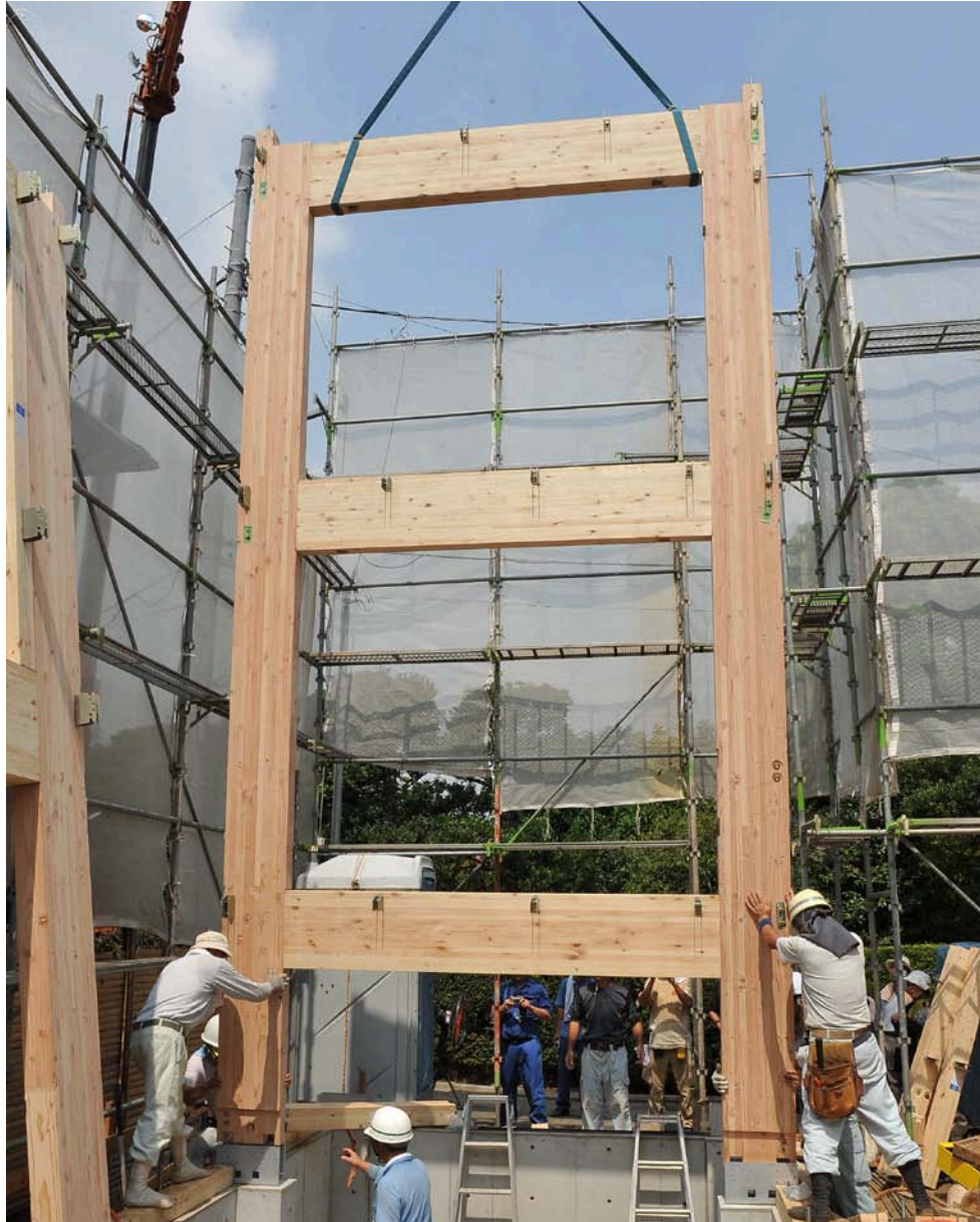
写真 5 ラーメン架構の設置
