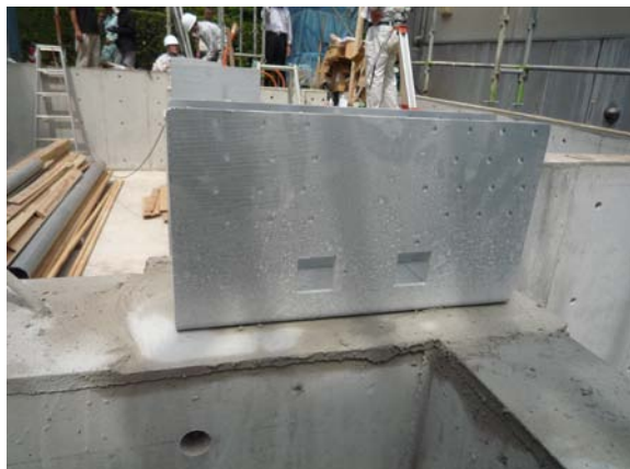
(14) 柱脚金物の設置状況（はつったモルタル） 基礎天端に不陸ができる
