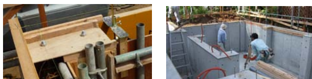
写真2 アンカーボルト設置と基礎天端レベルの確認
