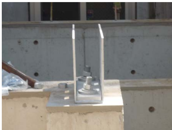
(15) 柱脚金物の設置状況 最もボルトが曲がっている例
