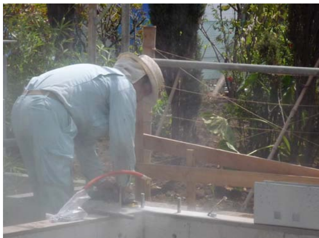
(11) 基礎天端レベル調整（均しモルタルはつり） レベル差は6mm程度、グラインダーではつる
