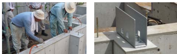
写真3 アンカーボルト位置確認と柱脚金物の設置
