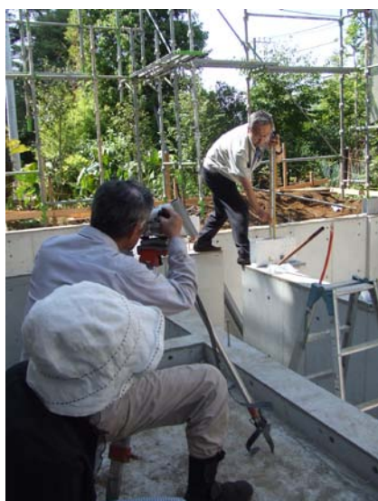
(16) 柱脚金物のレベルの確認 レベル差は3mm程度
