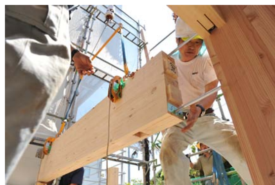
写真 6 直交梁の設置とラーメン梁(片側ピン)の設置
