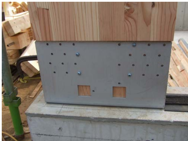
(25) 柱脚金物のビスの仮止め
