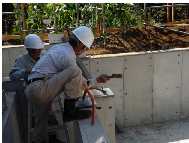
(13) アンカーボルトの台直し
