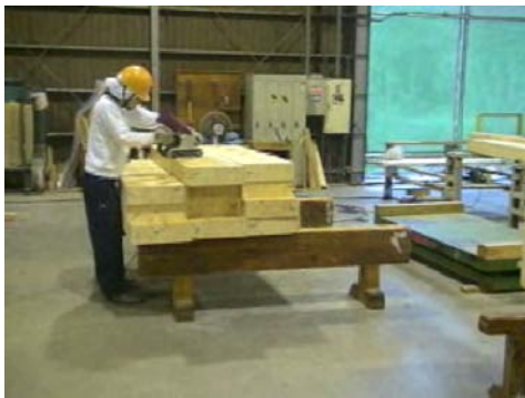
図 2-21 サンダにより材の汚れをとる
