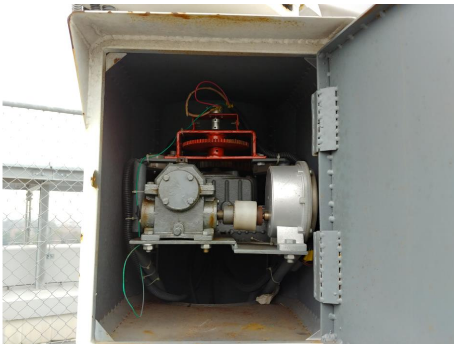
図 2.6 放物面集光器の回転のためのモーター.
