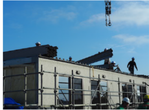
屋根折板取り外し
