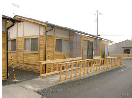
左写真：木造パネル化仮設住宅写真 右写真：使用されている壁パネル
