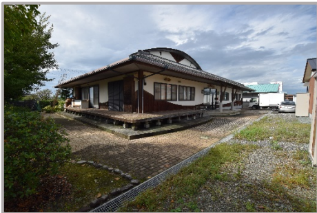
写真 野津仮設団地隣接交流施設
