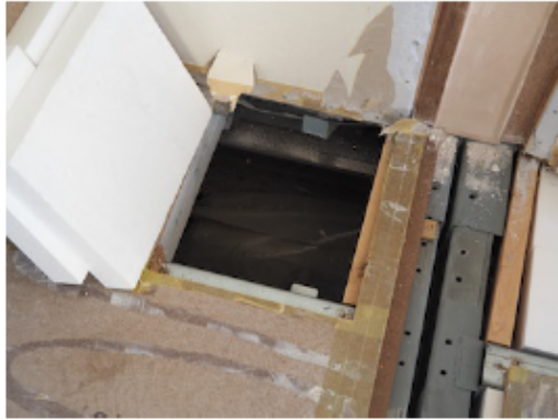
床下地解体部分
