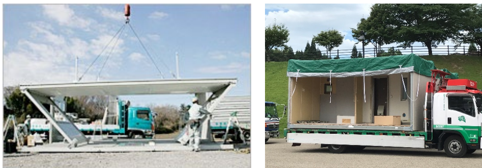
左写真：折り畳み式のユニット 写真右：住宅メーカーのユニット
