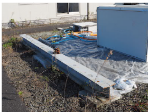
コンクリートブロックとH型鋼の基礎
