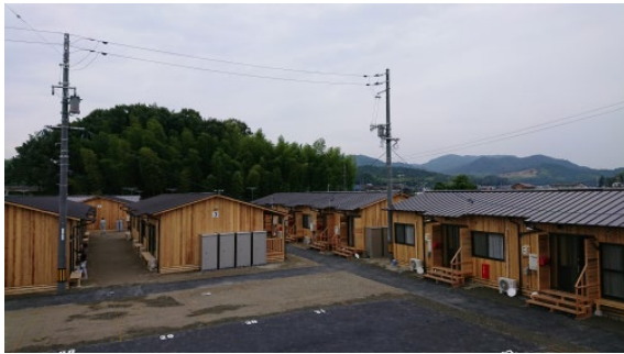
岡山県全木協仮設住宅写真
