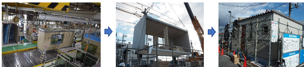
図 5.2-1 図 5.1-2 施工手順
