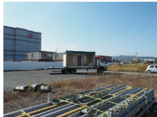
住戸ユニットの搬送
