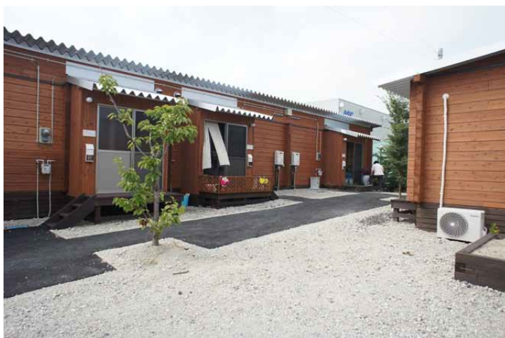
丸太組構法仮設住宅写真
