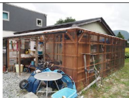
外周の増築部分
