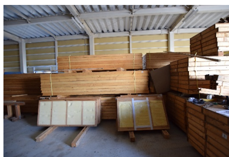
左写真：木造パネル化仮設住宅写真 右写真：使用されている壁パネル
