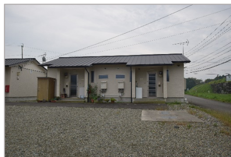
写真 改修後：上止まり山仮設団地仮設住宅
