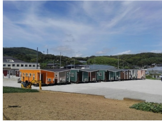
岡山県トレーラーハウス仮設住宅写真
