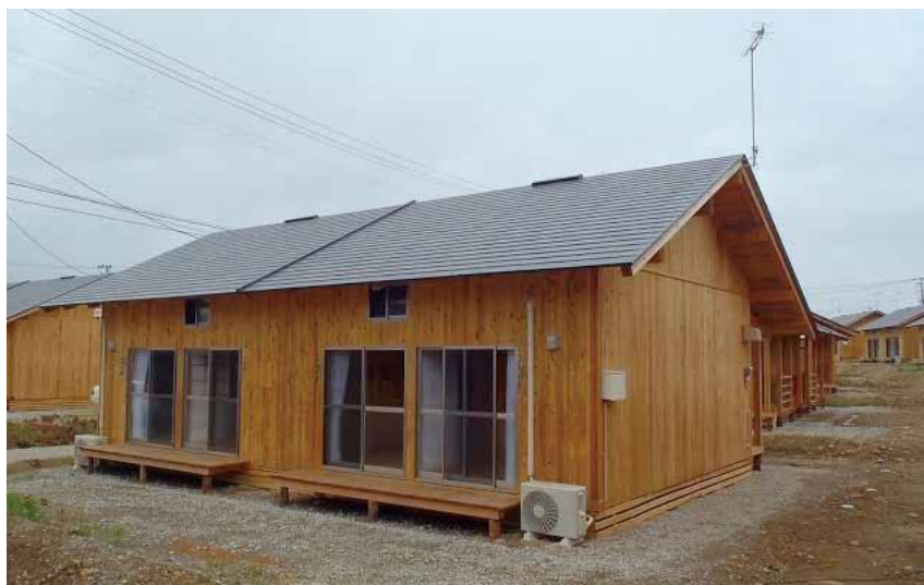
板倉構法仮設住宅写真
