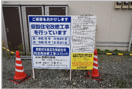
写真 小森第一仮設団地工事看板
