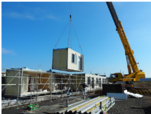
住戸ユニットの吊り上げ
