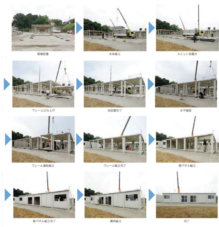
図 5.2-1 図 5.1-1 施工手順 引用 [1]
