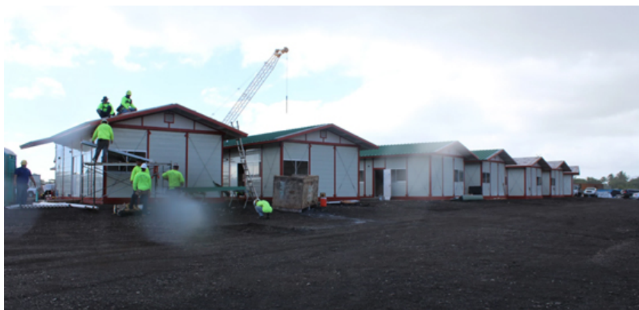
フェーズ 2 での現地での建築の様子写真
