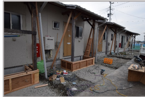
写真 小森第一仮設団地工事現場
