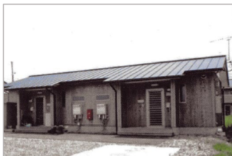
写真 改修前：上止まり山仮設団地仮設住宅 熊本県土木部提供資料より
