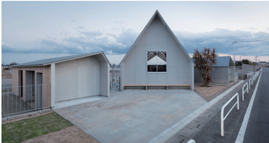
fig2-2-7.RFA 鶴ヶ島太陽光発電所環境教育施
