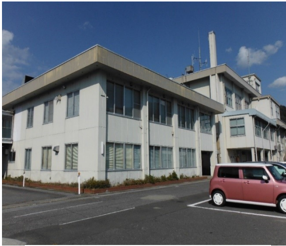
図 3-15 余呉まちづくりセンター改修前 [長浜市提供]
