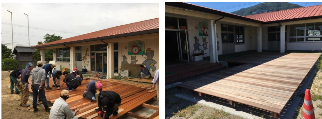
図 4-13 ウッドデッキとその作成の様子 [有田川町提供]
