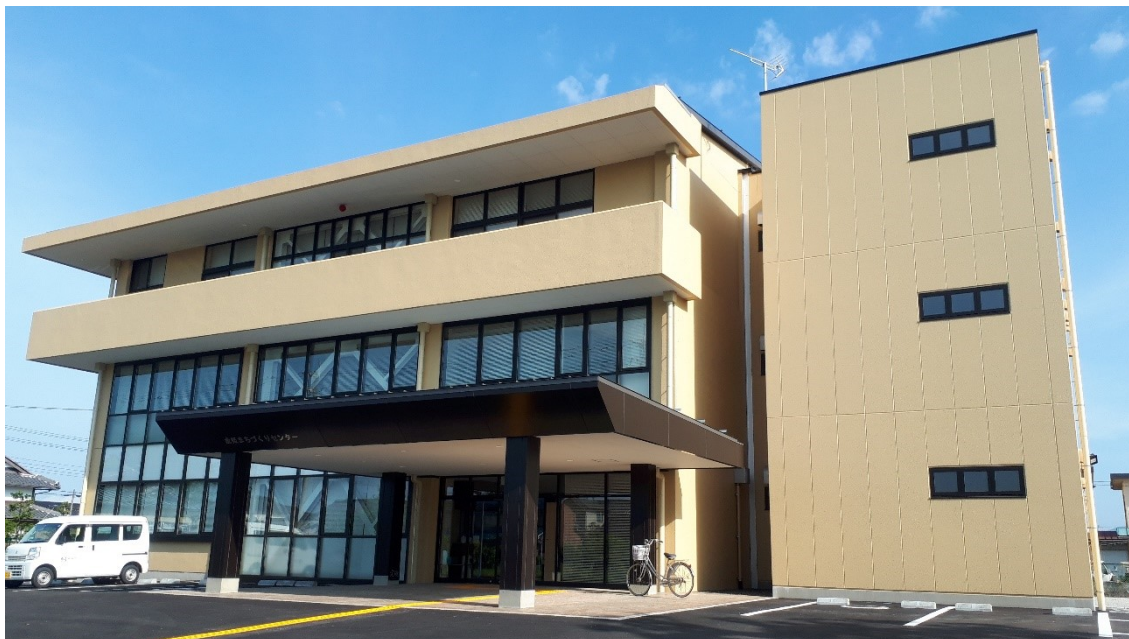
図 3-6 虎姫まちづくりセンター外観
