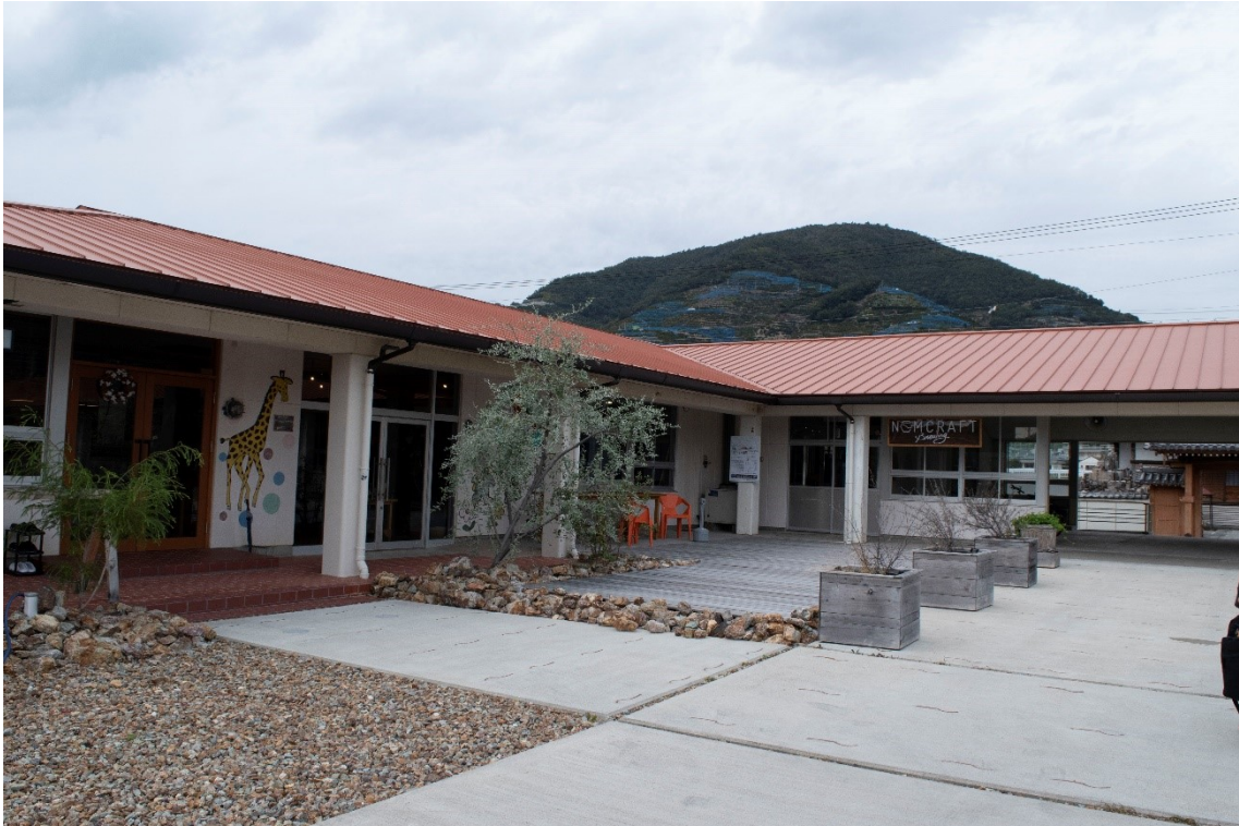
図 4-2 THE LIVING ROOM 外観
