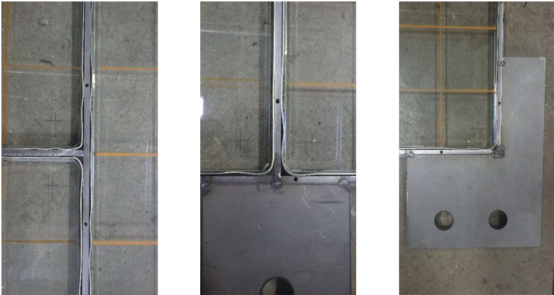
図 2.5 骨組とガラスの間に錫が挿入されている様子
