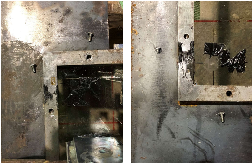
図 2.37 ビスが変形、破断している様子
