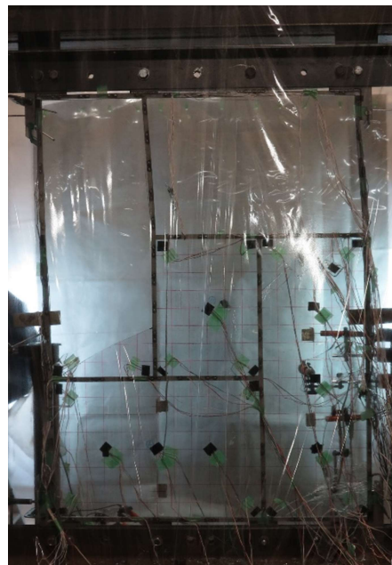
図 2.22 損傷経過写真 (2)
