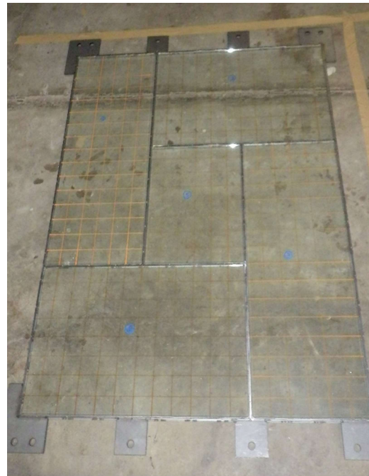
図 2.4 ガラスが全てはめ込まれた様子
