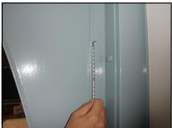
図 3-19 鉄骨方杖溶接部調査
