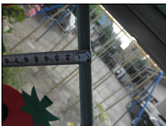
図 3-23 丸鋼ブレース寸法調査
