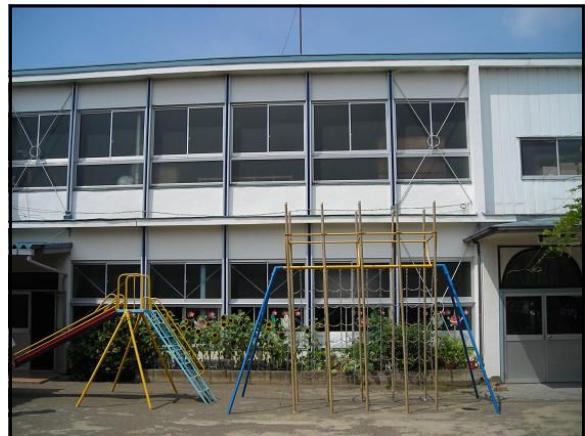
図 3-9 外壁面の丸鋼ブレース
