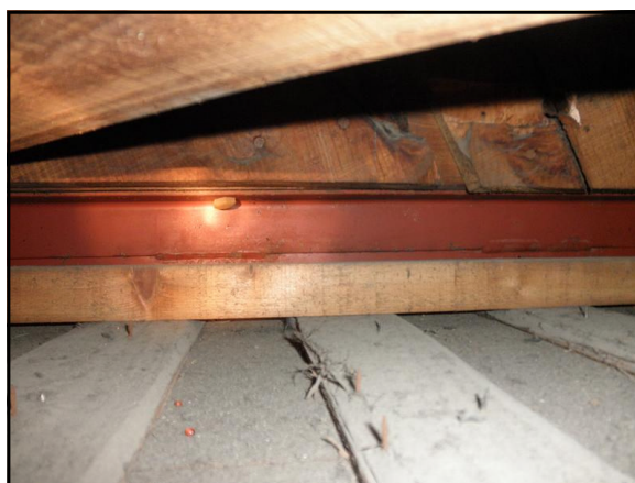
図 3-26 鉄骨方杖の取り付けボルト
