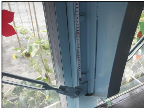
図 3-20 鉄骨方杖取り付けボルト間隔調査
