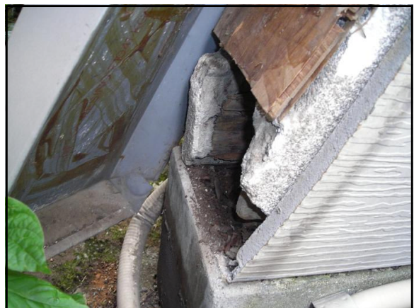
図 3-43 バットレス脚部の劣化
