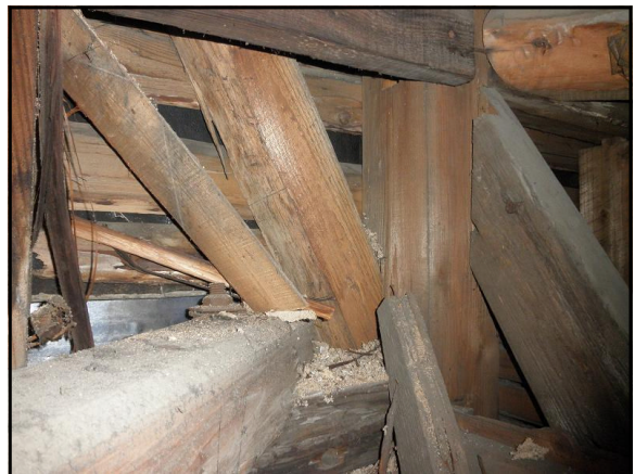
図 3-31 2 階筋かいと 1 階筋かい
