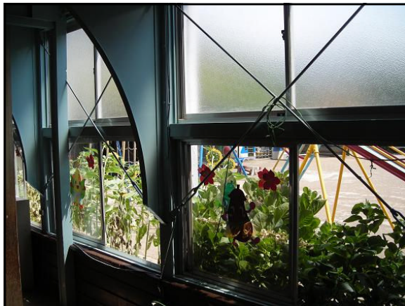
図 3-8 1 階室内の丸鋼ブレース
