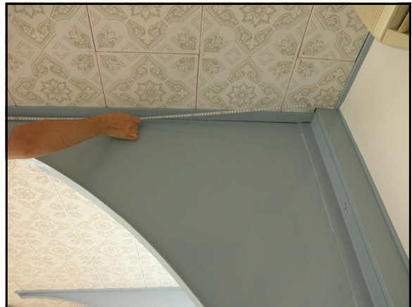
図 3-17 鉄骨方杖寸法調査
