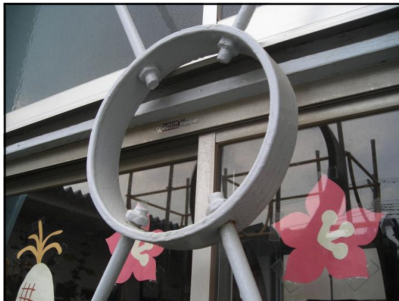
図 3-40 外付け丸鋼ブレース中央リング
