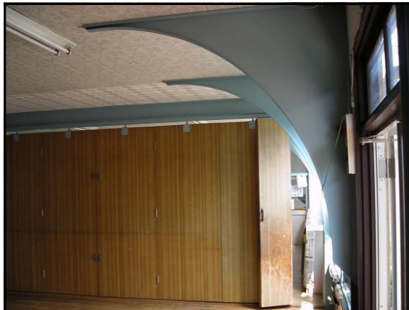
図 3-16 鉄骨方杖補強
