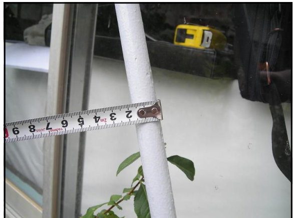
図 3-41 外付け丸鋼ブレースの径の測定
