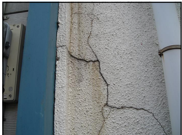
図 3-47 軽量鉄骨増築部との境界部
