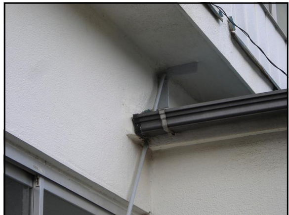
図 3-39 外付け丸鋼ブレース端部
