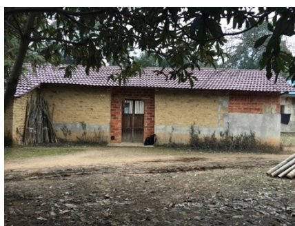
図 45:住宅(土と焼成煉瓦が混在する組積造、▲)
