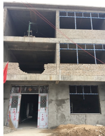
图 63:住宅(架構式構造、建設中)
