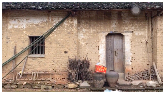
図 42:住宅(土の組積造、●)
