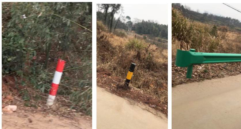
図 32:道路施設(違う種類のガードレール)
