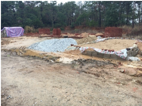
図 52:住宅(焼成煉瓦の組積造、建設中)
