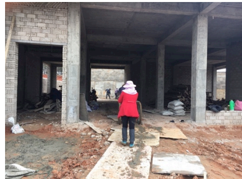
图 61:住宅(架構式構造、建設中)
