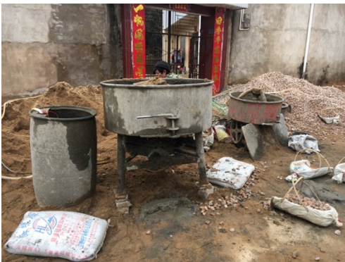
图 62:住宅(架構式構造、建設現場)
