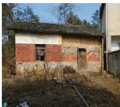
図 44:住宅(土と焼成煉瓦が混在する組積造、○)
