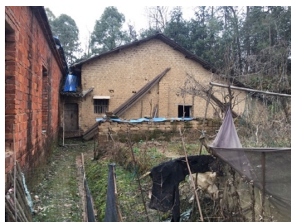
図 41:住宅(土の組積造、▲)
