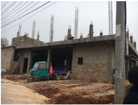
图 60:住宅(架構式構造、建設中)
