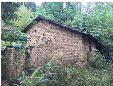
図 40:住宅(土の組積造、×)
