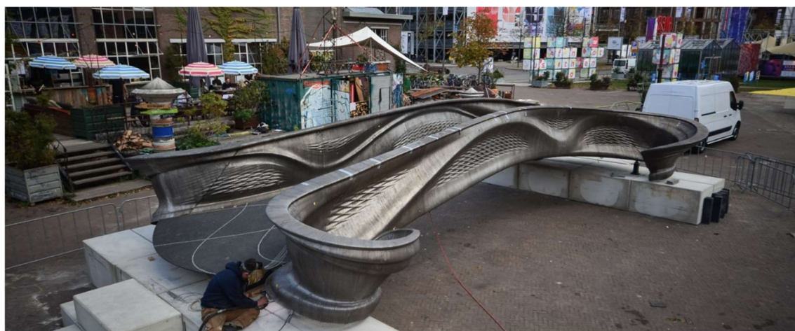
図 1.1 MX3D と Autodesk 社によるステンレス 3D プリント製の橋 [5]
