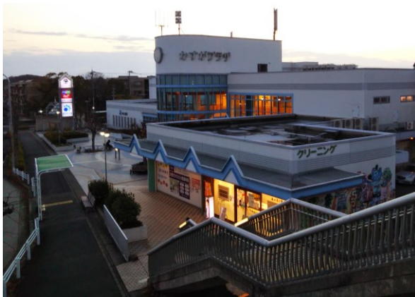
写真4 コープ西神店が入っている建物
