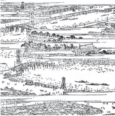
fig-3-4-2-2-1-2 火の見櫓は堀を背に建っており、下部は何も無く広場になっており、前面に大通りがある。火の見櫓は接触している街区の中で一番高い建物である。
