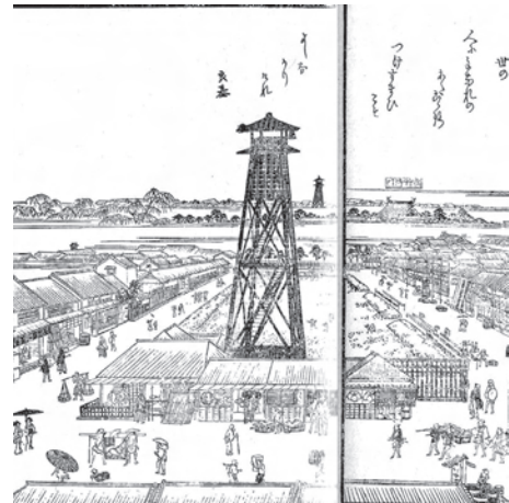
fig-3-4-2-2-1-5 火の見櫓は馬場を背に建っており、通りとは接していない。火の見櫓は接触している街区の中で一番高い建物である。
