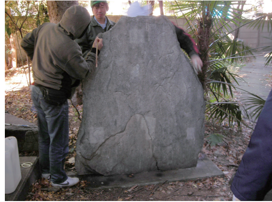
中央上部と中央下部、右側の部分共に洗浄で白くなった部分。かなり黒く汚染されている。言問通りの排気ガスの黒灰か。
