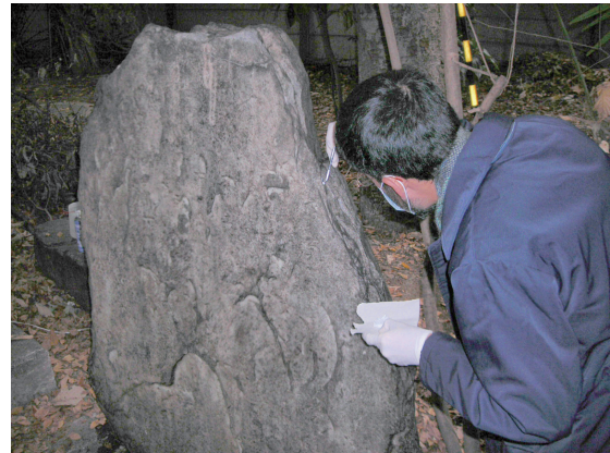
側面の亀裂にエキポシ樹脂(アラルダイト6504)の充填
