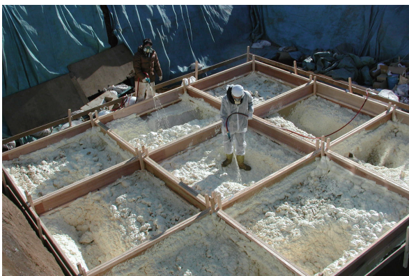
ウレタンフォームの吹きつけ作業。大量なウレタンを使用するため防毒マスクが必要。後に分割できるように木枠を組んでいる。
