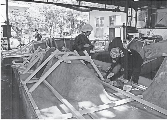
写真9 角材による補強
