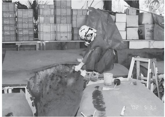
写真14 土層に定着剤の吹き付け
