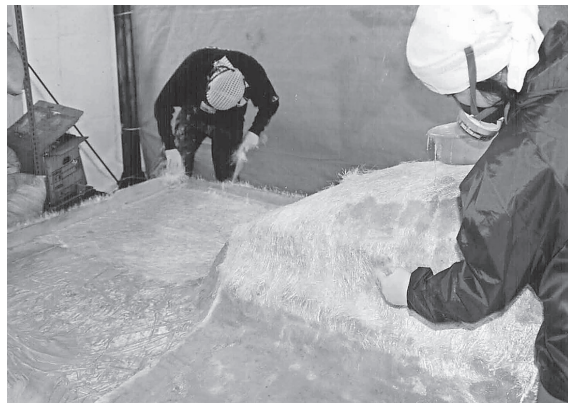
写真8 ガラス繊維による補強
