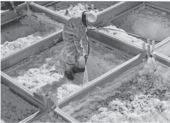
写真5 ウレタンフォームの吹き付けによる裏打ち
