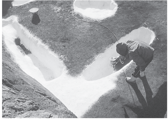
写真2 シリコンゴムの吹き付け
