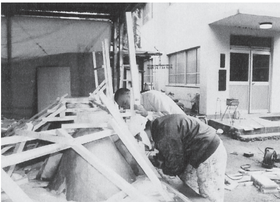
写真11 脚の取り付け
