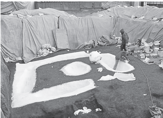
写真3 シリコンゴムの補強
