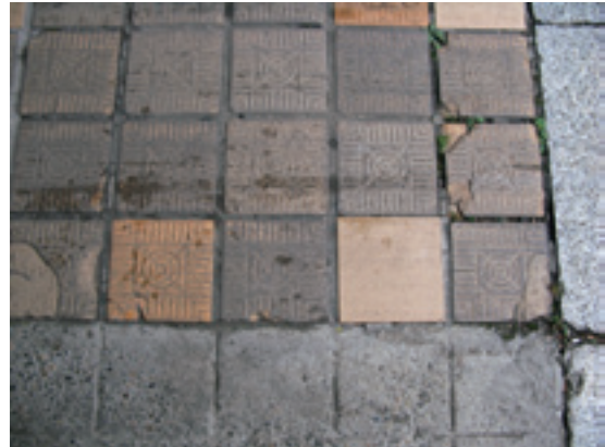
13 図 北側アーケード舗装復旧状況 (2)
