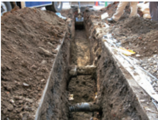
5図 トレンチ2掘削状況
