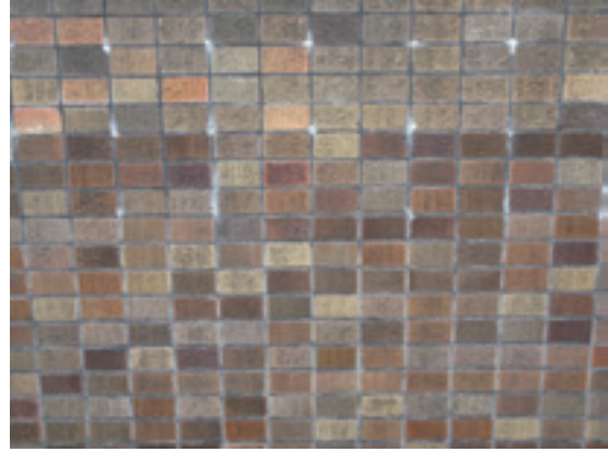
11 図 医学部附属病院管理研究棟外壁スクラッチタイル
