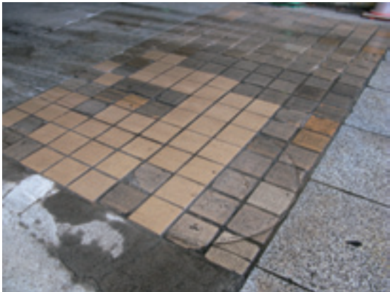
12 図 北側アーケード舗装復旧状況 (1)
