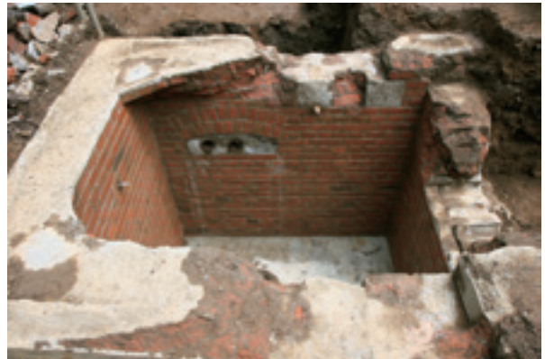
19図 SD29 煉瓦基礎内配管孔検出状況
