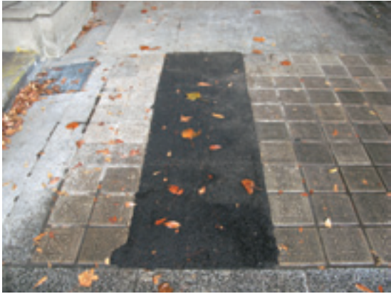
10 図 トレンチ 5-1 復旧状況
