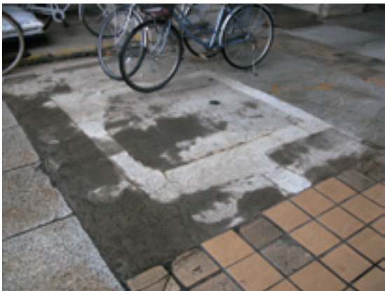
14 図 北側アーケード舗装復旧状況 (3)
