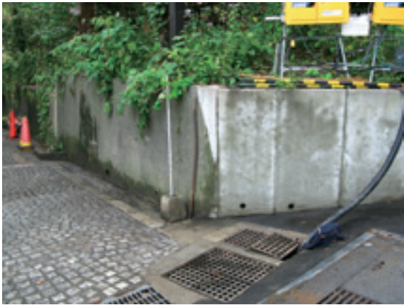
7図 ⑫擁壁撤去部分 (手前はC区)
