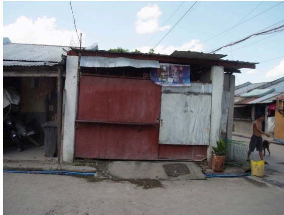
図 3-37 RC+Infill 造の事例（2020 年撮影）
