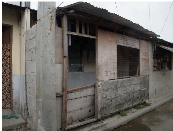
図 3-42 木造+CHB の事例 2 (2020 年撮影) - 木造の隙間に CHB
