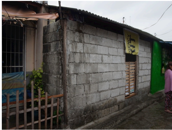
図 3-15 木造+CHB の事例 1 (2020 年撮影) - RC 柱の代わりに木柱
