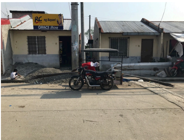
図 4-12 モルタルの材料を屋外で管理
