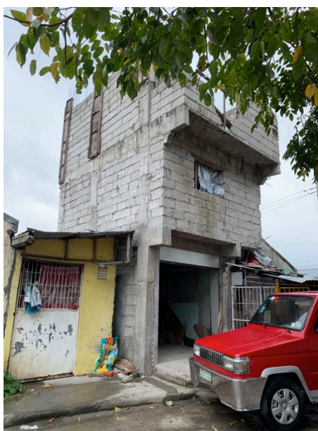
図 2-3 資材投入が少なく建設の質が低い3階建増築の例
