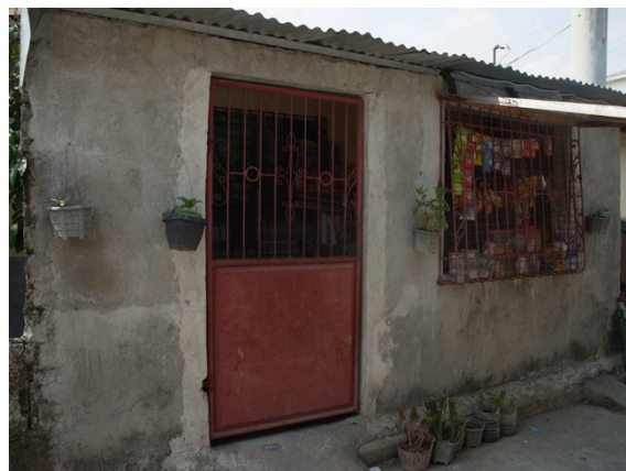
図 3-28 上半分が金属フェンス、下半分が金属板の扉の例
