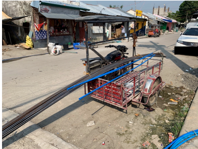
図 4-11 資材の運搬方法
