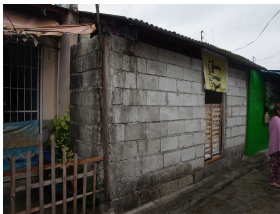
図 3-46 木造+CHB、RC 柱・梁の代わりに木材を使用している事例（2020 年撮影）
