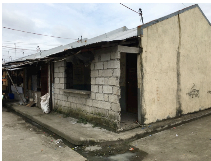
図 3-47 CHB 造、柱なし、側面壁なしの事例（2016 年撮影）
