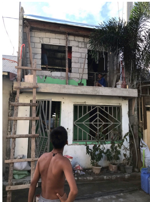
図 4-14 プロジェクト2の現場写真（2020年撮影）
