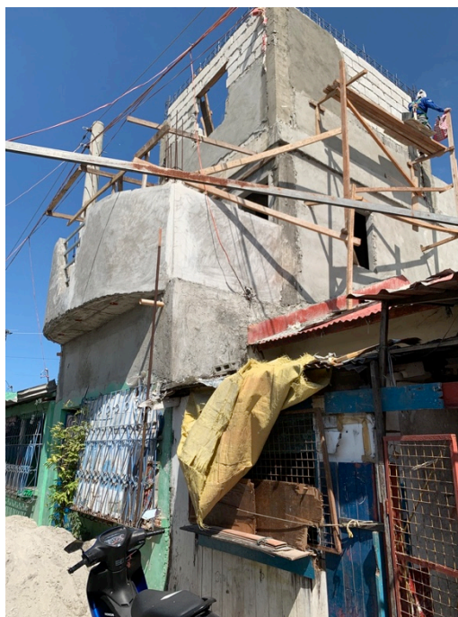
図 4-13 プロジェクト1の現場写真(2020年撮影)
