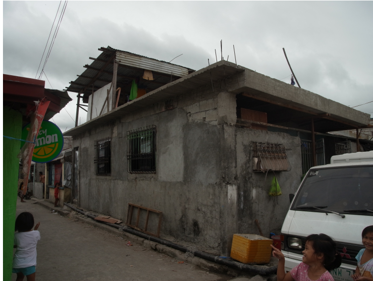
図 5-2 1階：コンクリート系構造、2階：木造の例（2020年撮影）
